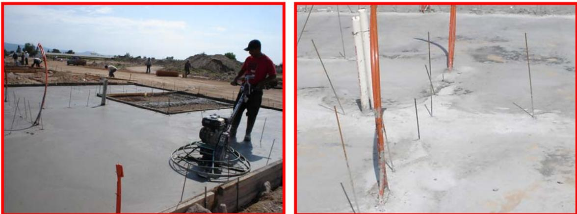
**Foto 5.1: El agrietamiento por contracción plástica fue eliminado totalmente al utilizar arena volcánica en el diseño y elaboración de la mezcla de concreto para la construcción de viviendas de interés social.**
