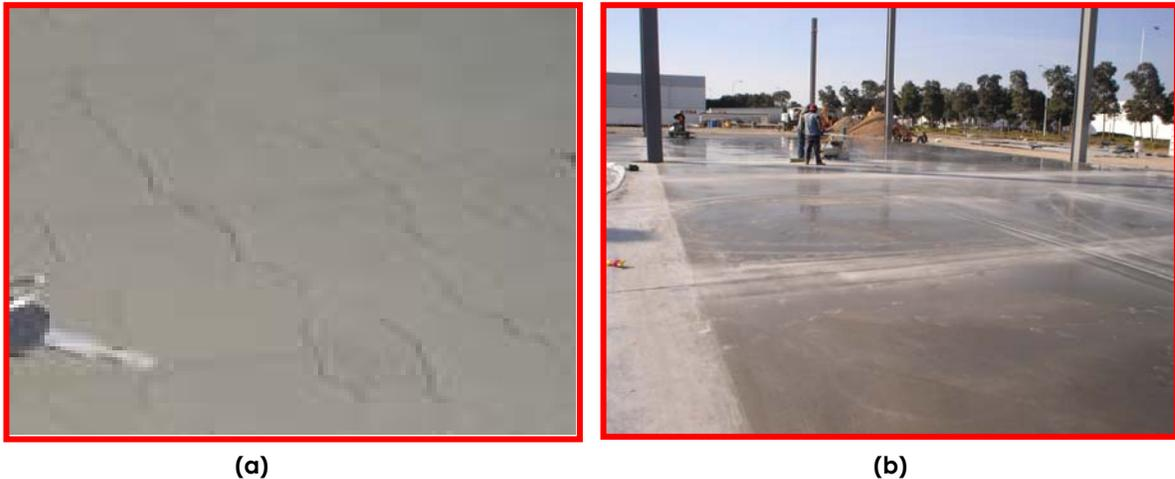
**Foto 5.2:** En la foto (a) se observan las grietas por contracción plástica generada por la falta de protección de las condiciones ambientales y, en la foto (b) se tiene una vista del piso, completamente sin grietas, después de rediseñar la mezcla incorporando arena volcánica.
