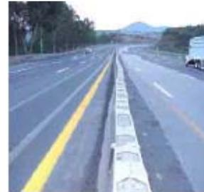
Fotografías VI. 2 y VI. 3. Ejemplos de medianas angostas con barrera de concreto
