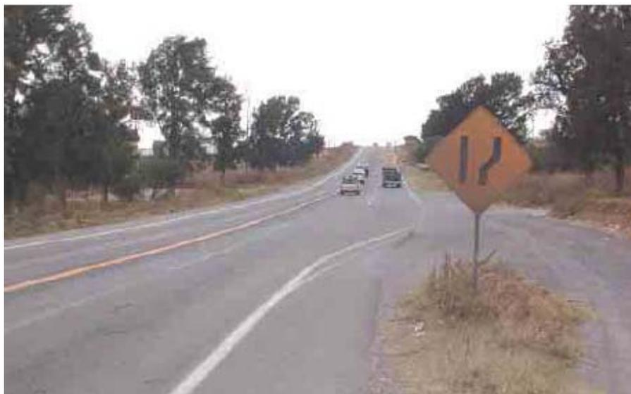
FigurasVI. 7. Vista del inicio y terminación de un tercer carril de ascenso en una carretera de un carril por sentido
