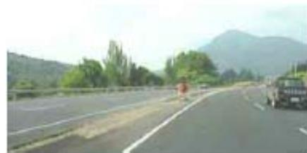
Fotografías VI. 4 y VI. 5. Ejemplos de medianas sin ningún tipo de barreras
