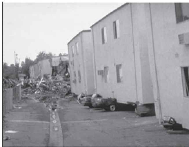
Figura 1.3 Estructuras que colapsaron debido a la presencia del primer piso blando.
