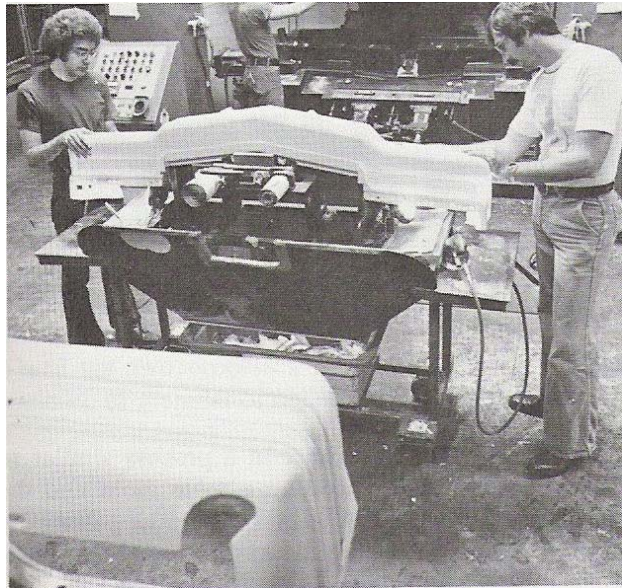
Moldeo de pieza por proceso de RIM
