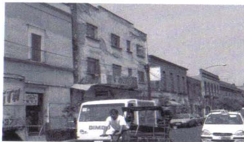
PODEMOS VER LA DIFERENCIA DE LAS ALTURAS COLINDANTES DE LOS EDIFICIOS ASI COMO EL DESCUIDO EN LAS FACHADAS
