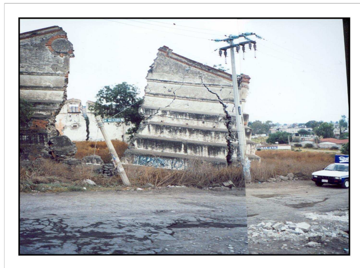
Figura 5.8. Exhacienda de Xico ubicada en el cruce de Av. A. López Mateos y calle Paso de Cortés en la ladera inferior del cono. Febrero de 2005.
