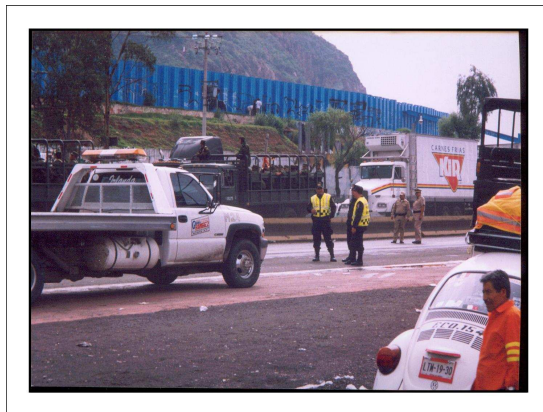
Figura 5.2. La barda azul es la parte reconstruida del canal de La Compañía que se rompió. Agosto de 2005 sobre la carretera federal de cuota No 190, frente al cerro Tlapacoya.
