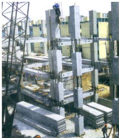
Fig. 1.8.35- Columnas con ventana
