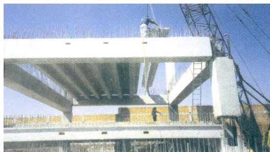
Fig. 1.8.37- Montaje de vigas TT
