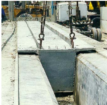
Fig. 1.11.18- Desmolde de trabe cajón
