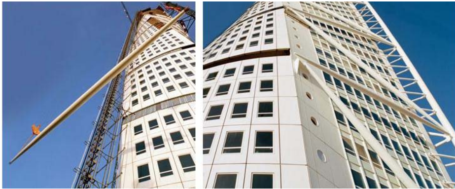
Fig. 2.1.57- Construcción del edificio
