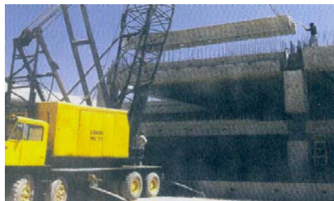
Fig. 1.8.36- Montaje de trabes portantes
