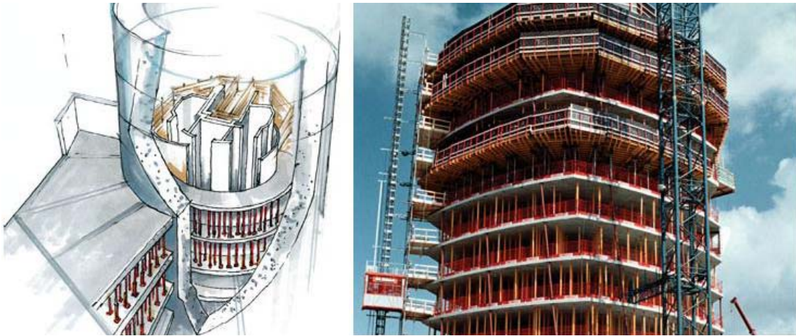
Fig. 2.1.45- Proceso de construcción
