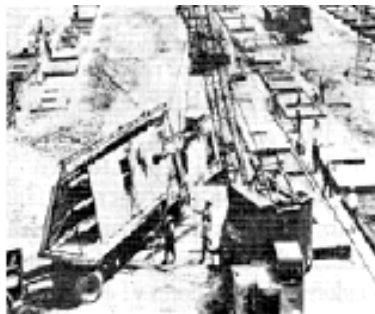
Fig. 1.2.10- Prefabricación a pie de obra
