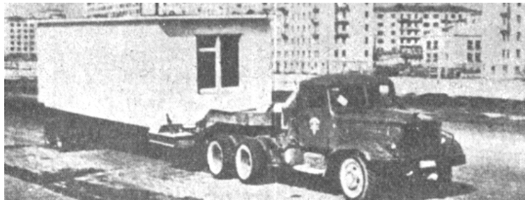
Fig. 1.4.7- Construcción a base de elementos espaciales. Transporte
