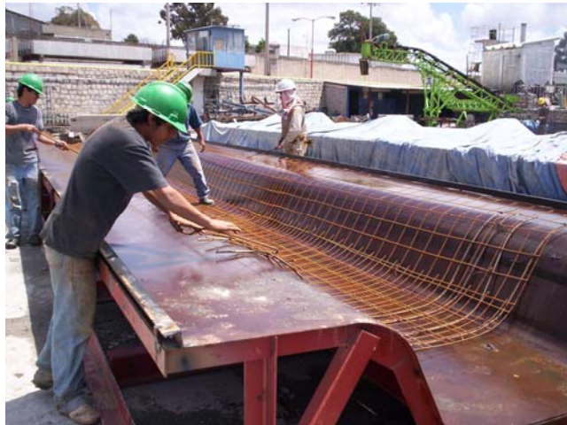
Fig. 1.11.2- Fabricación en obra de una viga omega para el proyecto Angelopolis ITISA
