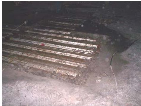
Fig. 2.1.69- Capa de compresión para vigas "TT"
