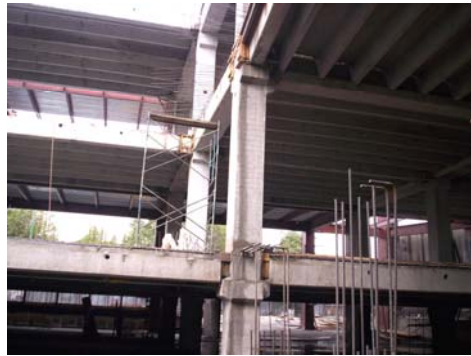
Fig. 2.1.61- Conexión de columnas a vigas
