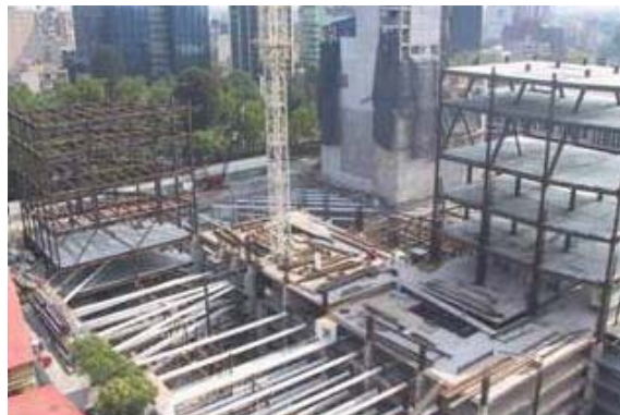
Fig. 2.1.24- Estructura de acero
