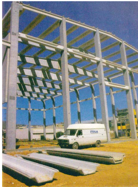
Fig. 1.8.1- Estructura del sistema Delta
