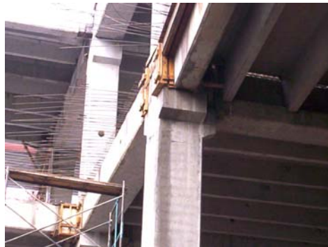
Fig. 2.1.62- Conexión de columnas a vigas
