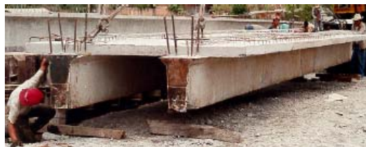
Fig. 1.11.19- Apoyos en almacenaje de traveses doble T
