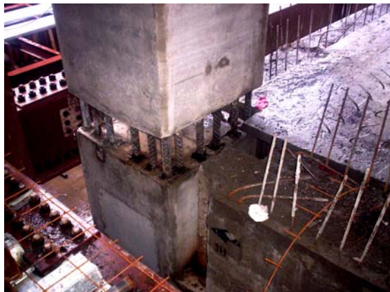
Fig. 2.1.59- Conexión de columnas a vigas
