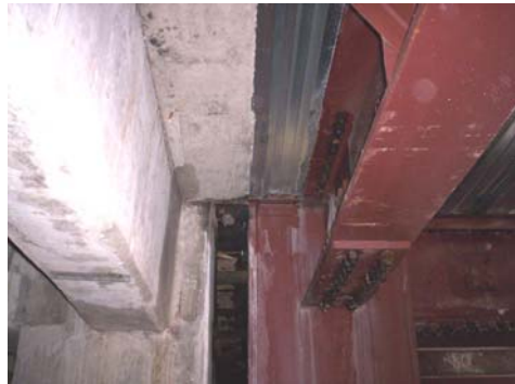
Fig. 2.1.73- Conexión de edificio de acero con edificio de concreto
