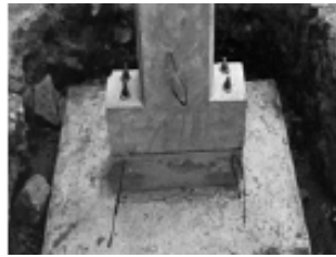
Fig. 1.2.8- Cimentación del sistema CAFCE
