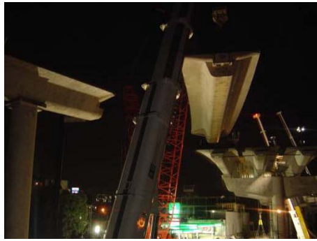
Fig. 1.2.13- Montaje nocturno de traves del Segundo piso del Periférico
