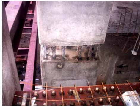
Fig. 2.1.60- Conexión de columnas a vigas
