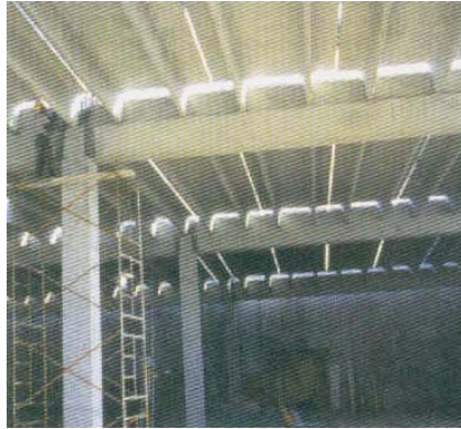
Fig. 1.8.34- Vigas portantes, columnas y trabes TT
