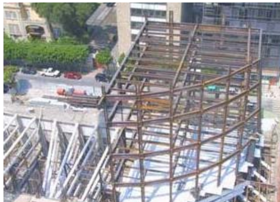
Fig. 2.1.25- Estructura de acero
