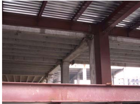
Fig. 2.1.72- Conexión de edificio de acero con edificio de concreto
