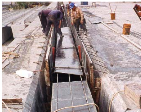
Fig. 1.11.5- Molde de concreto para trabe cajón
