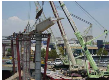
Fig. 1.2.14- Montaje de elementos del Segundo piso del Periférico
