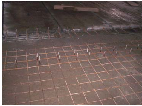
Fig. 2.1.68- Capa de compresión para vigas "TT"
