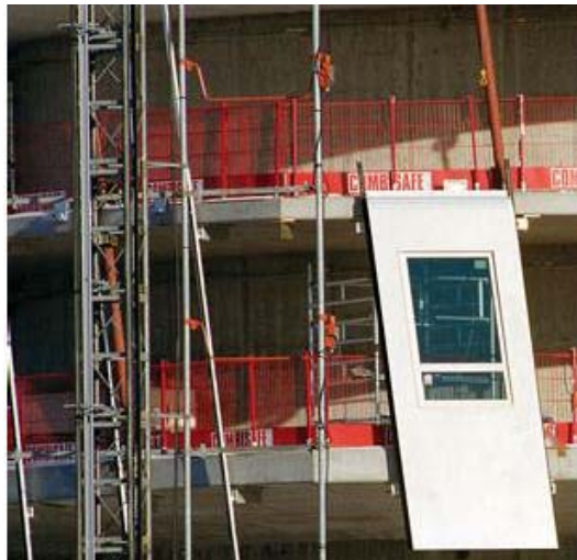
Fig. 2.1.50- Colocación de paneles de fachada
