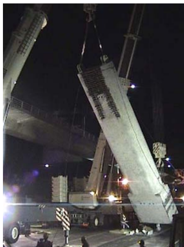
Fig. 1.2.12- Montaje de columna B-214 del Segundo piso del Periférico
