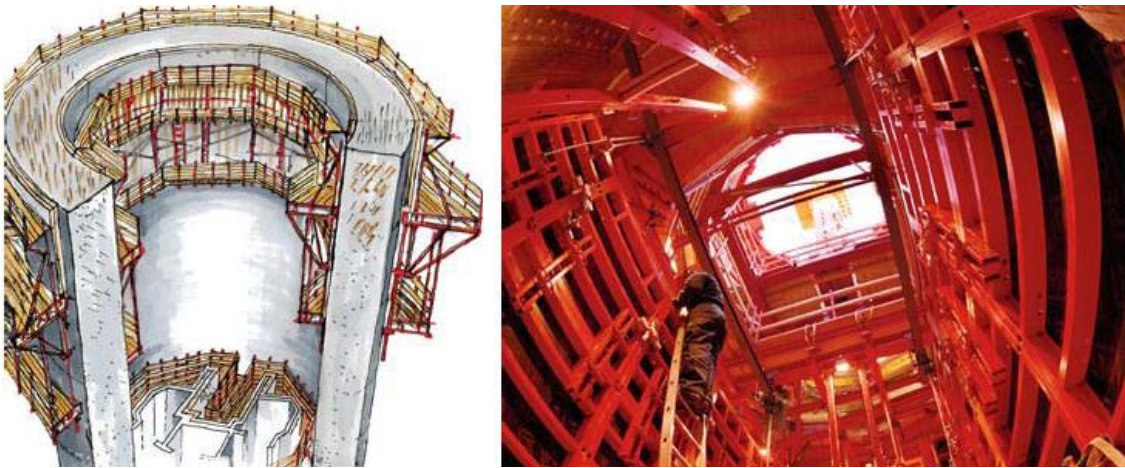
Fig. 2.1.46- Proceso de construcción
