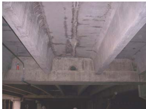
Fig. 2.1.75- Pasos de instalaciones
