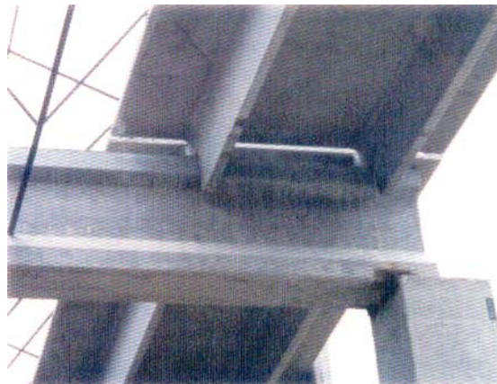
Fig. 1.8.12- Detalle de viga y losa nervada
