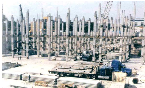
Fig. 1.8.20- Colocación de columnas
