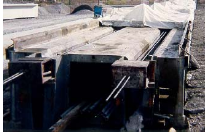
Fig. 1.11.17- Vista de elementos curados a vapor
