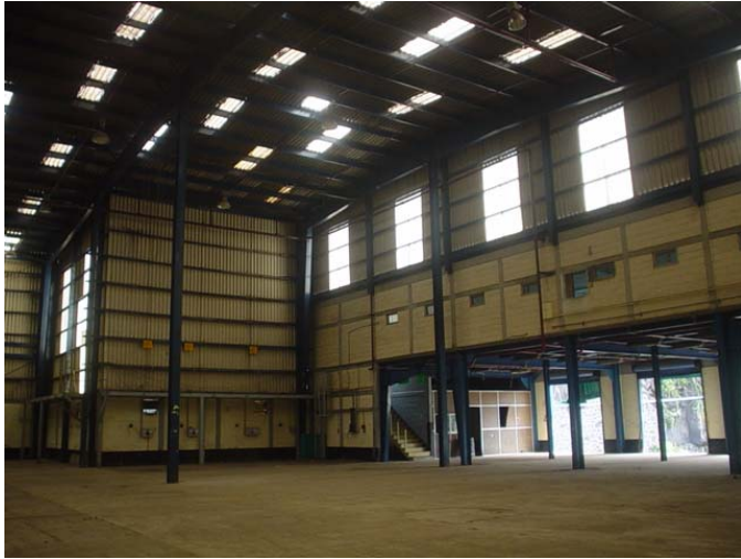
Vista 9 interior del área oficinas
