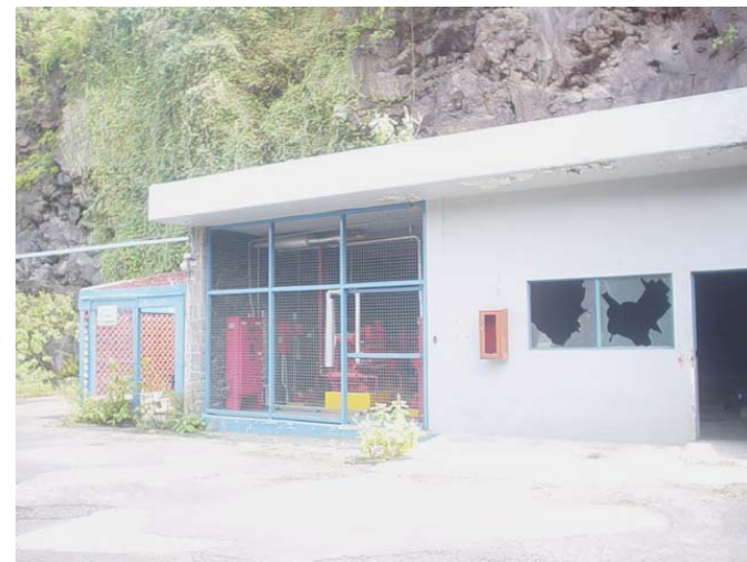
Vista 6 de cuarto de maquinas existente
