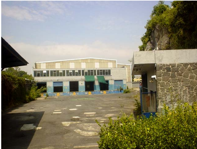
Vista 7 del fondo del terreno a la Nave existente
