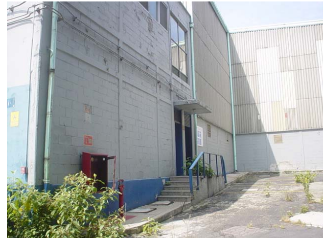
Vista 8 lateral de la Nave
