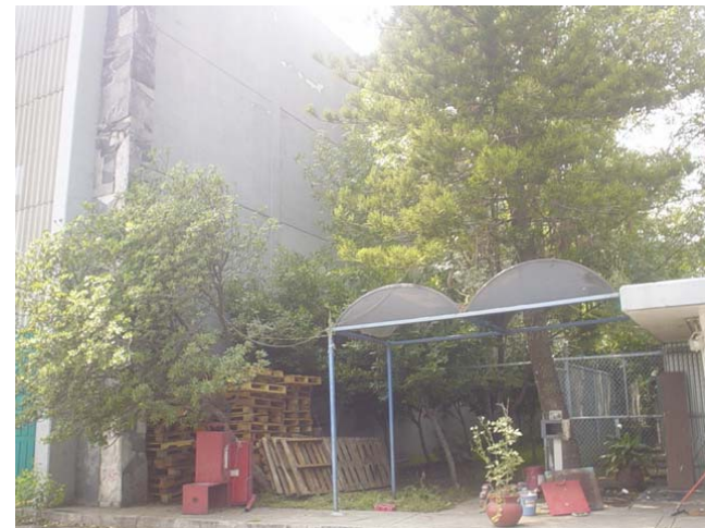
Vista 2 de caseta acceso al predio
