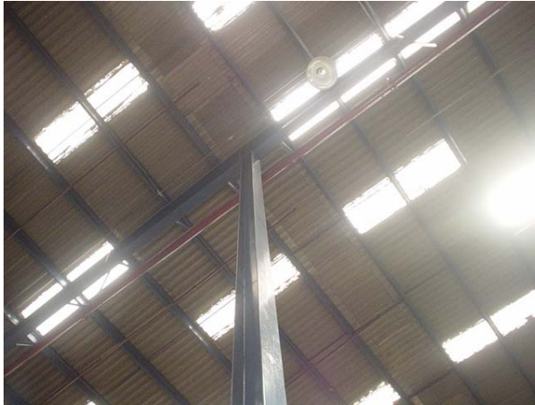
Vista 13 de la estructura de la cubierta
