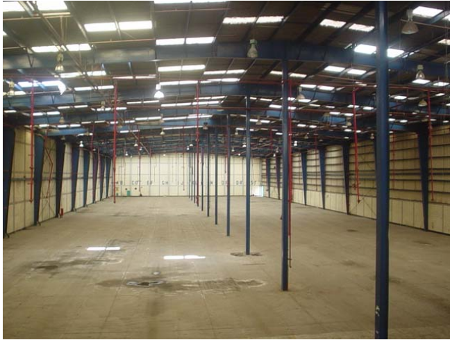
Vista 11 interior de Nave que se aprovechara para el proyecto.
