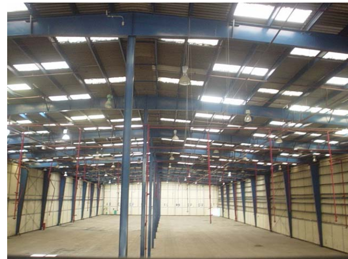
Vista 10 interior de la Nave del área a modificar y ampliar
