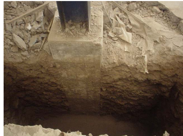
Vista 12 Cala, cimentación de la estructura
