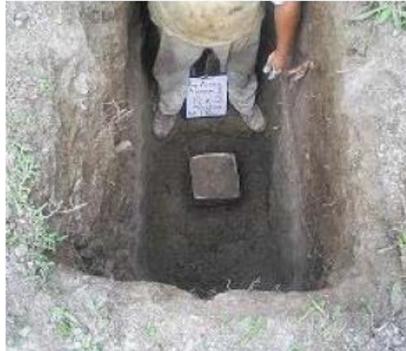
**Fotos 2 y 3.** Extracción de muestras cúbicas; se sacaron muestras en todos los pozos a profundidades variables entre 1.00 y 1.75 m. Posteriormente en éstas muestras se labraron probetas para realizar pruebas triaxiales tipo UU y consolidada rápida. Extracción de muestras representativas en los pozos a cielo abierto; se sacaron muestras a cada 10 cm para posteriormente obtener los contenidos de agua y límites en el laboratorio de mecánica de suelos.
