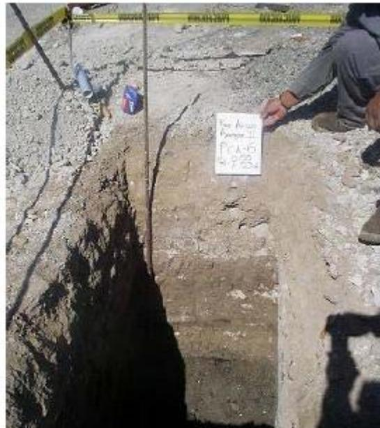
**Fotos 4 y 5.** Se observan los materiales que componen la costra superficial. En algunos de los pozos se detectaron rellenos, arcillas de alta plasticidad y losas de concreto de 0.4 m de espesor; esto generalmente en los primeros 0.80 m; de los 0.80 m a la profundidad máxima explorada (2.40 m), en los pozos, se detectaron limos de alta plasticidad con algunos lentes de arena.
