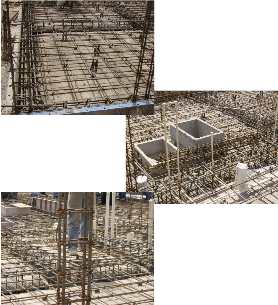
**Figura 16.** Armado en losas e instalaciones
