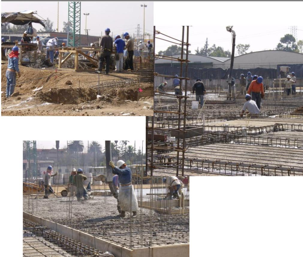
**Imagen 17.** Colado de la losa de cimentación.
