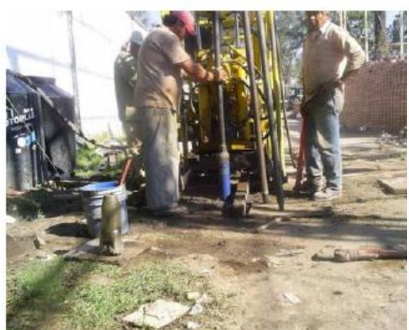
**Fotos 13 y 14.** Trabajos correspondientes al muestreo selectivo. Aprovechando la información geotécnica obtenida en los sondeos de cono eléctrico y de penetración estándar se definieron los estratos representativos para la extracción de muestras inalteradas y con ellas definir los parámetros, posteriormente en el laboratorio de mecánica de suelos, de resistencia y de deformabilidad.
