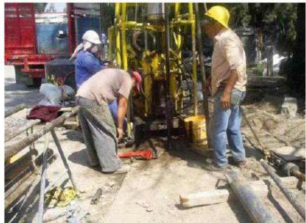
**Fotos 10, 11 y 12.** Realización de los sondeos de penetración estándar. Se realizaron tres con el propósito de confirmar el contacto de la capa dura detectado en los sondeos de cono eléctrico. El SPT-2 se realizó hasta los depósitos profundos; es decir hasta 45.0 metros. Además se aprovecharon las muestras obtenidas para determinar los contenidos de agua y porcentaje de finos de los materiales encontrados.
