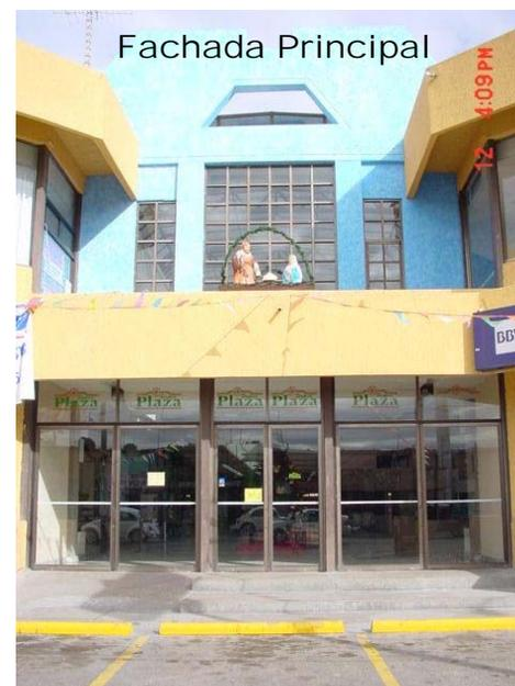
El área cuenta con una superficie de 2,410 m<sup>2</sup> construidos, es un inmueble con muros de carga perimetrales y al centro columnas de carga con travesaños portantes, los entrepisos y la cubierta son a base de vigas "TT", en la adaptación se reubicaron el 1er. 2do. 3er. Y 4to. Juzgados de Distrito de la ciudad de San Luis Potosí, S.L.P.
