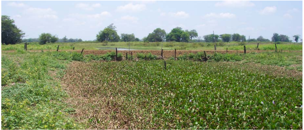
Foto 5.9 Para el tránsito vehicular interno entre los terrenos productivos se construyen terraplenes transversales a los cauces, lo que ocasiona la obstrucción total del mismo y a su vez, provoca remansos y desbordamientos de los escurrimientos hacia las llanuras, convirtiéndolas en zonas inundada.
