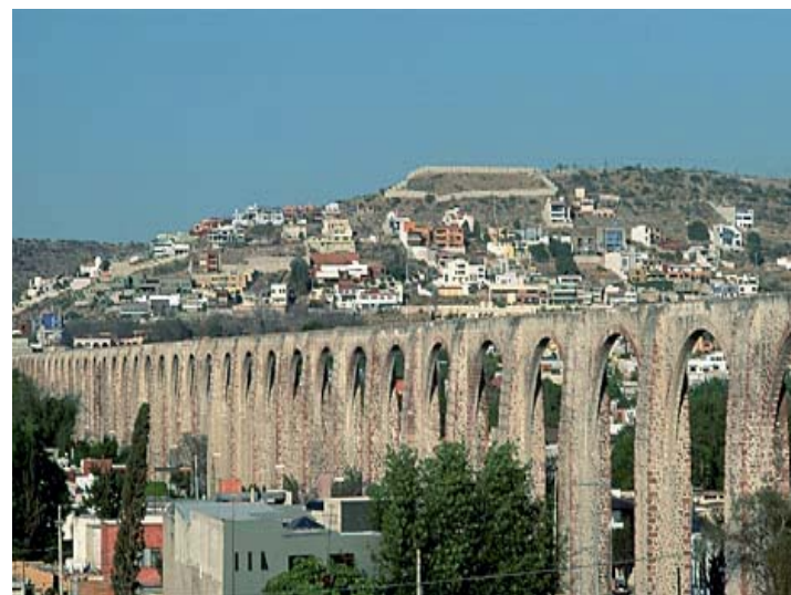
Foto tomada del centro de Querétaro vista hacia el acueducto que se encuentra en la avenida principal
