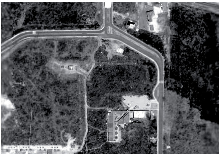
Vista aérea de los predios colindantes
