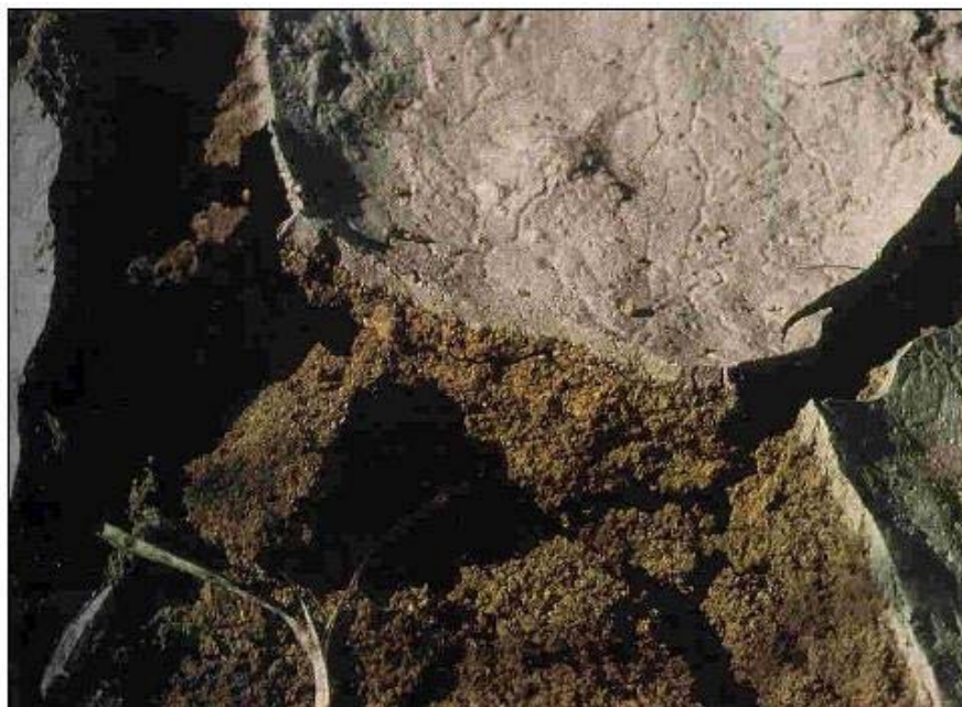
Figura 4.28. Costra debida a la colmatación química
