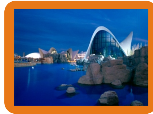
Vista general del conjunto.
