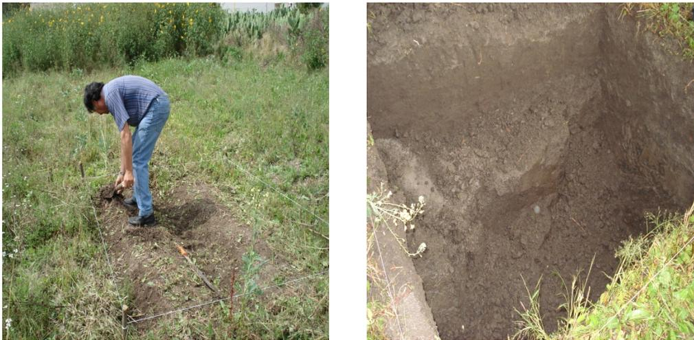
Figura 4.2. Estas fotografías muestran: (a) El recuadro que se hizo al iniciar la excavación. (b) La profundidad de 120 cm. a la cual se realizó la excavación.
