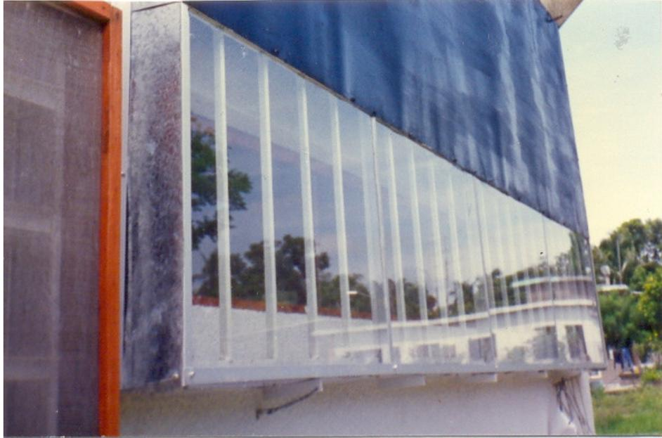
IMAGEN 38. CRISTAL TRANSPARENTE A LA ALTURA DE LA ENTRADA DE AIRE INTERIOR.
