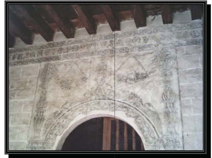
Foto 35. Acceso a las escaleras
