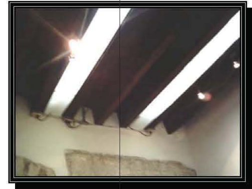
Foto 84. Adecuación de las luminarias
