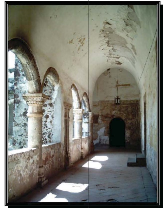
Foto 32. Pasillo norte, planta alta
