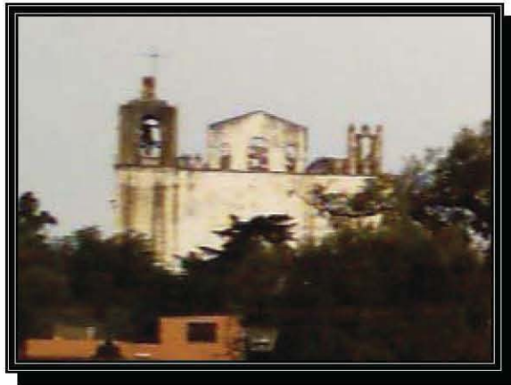
Foto 21. Fachada este de la iglesia
