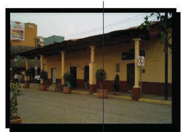
Foto 7. Fachada en la avenida principal
