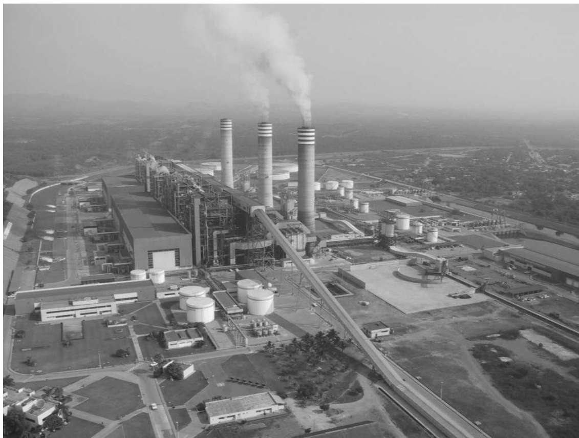
Figura 4.1: Vista de la Central Termoeléctrica Presidente Plutarco Elías Calles.
