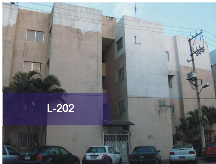
Fotografía. Fachada principal del condominio caso de estudio.
