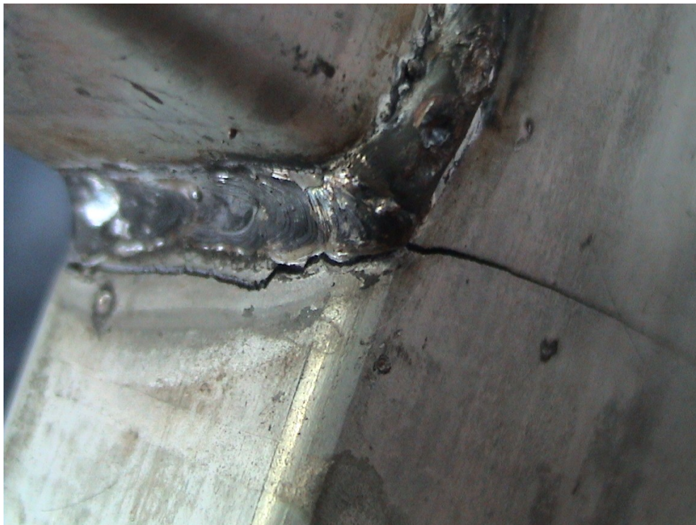
Figura 4-27. Grieta obtenida (acercamiento).
