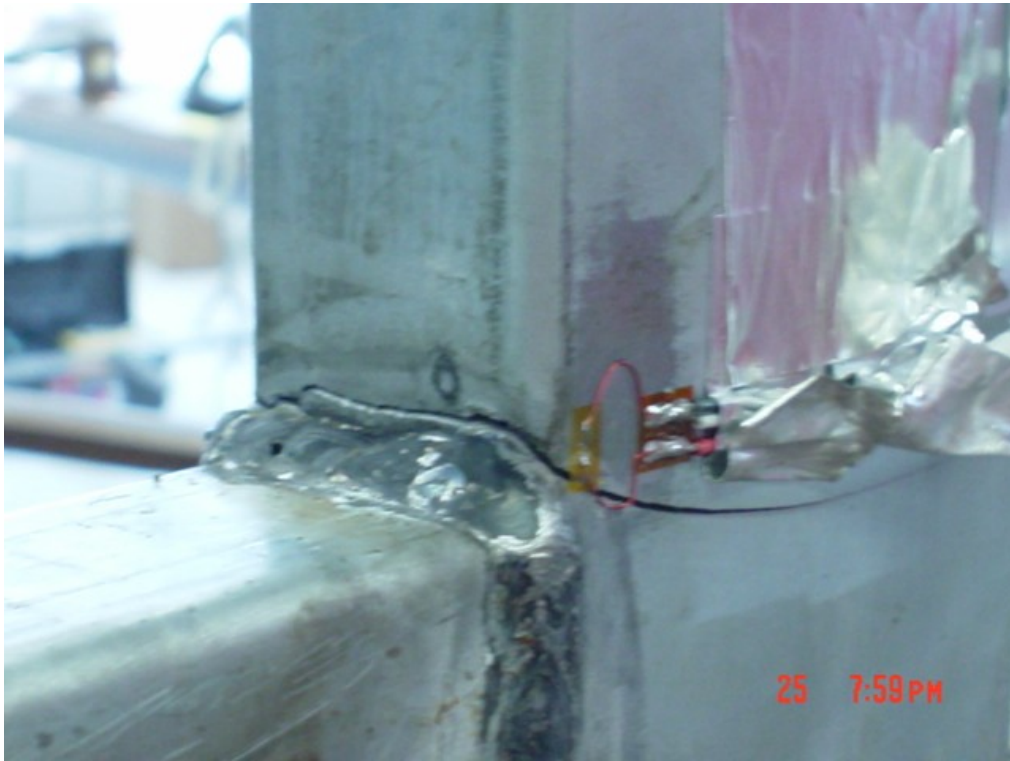
Figura 4-26. Grieta obtenida como resultado de la prueba de fatiga (vista exterior).
