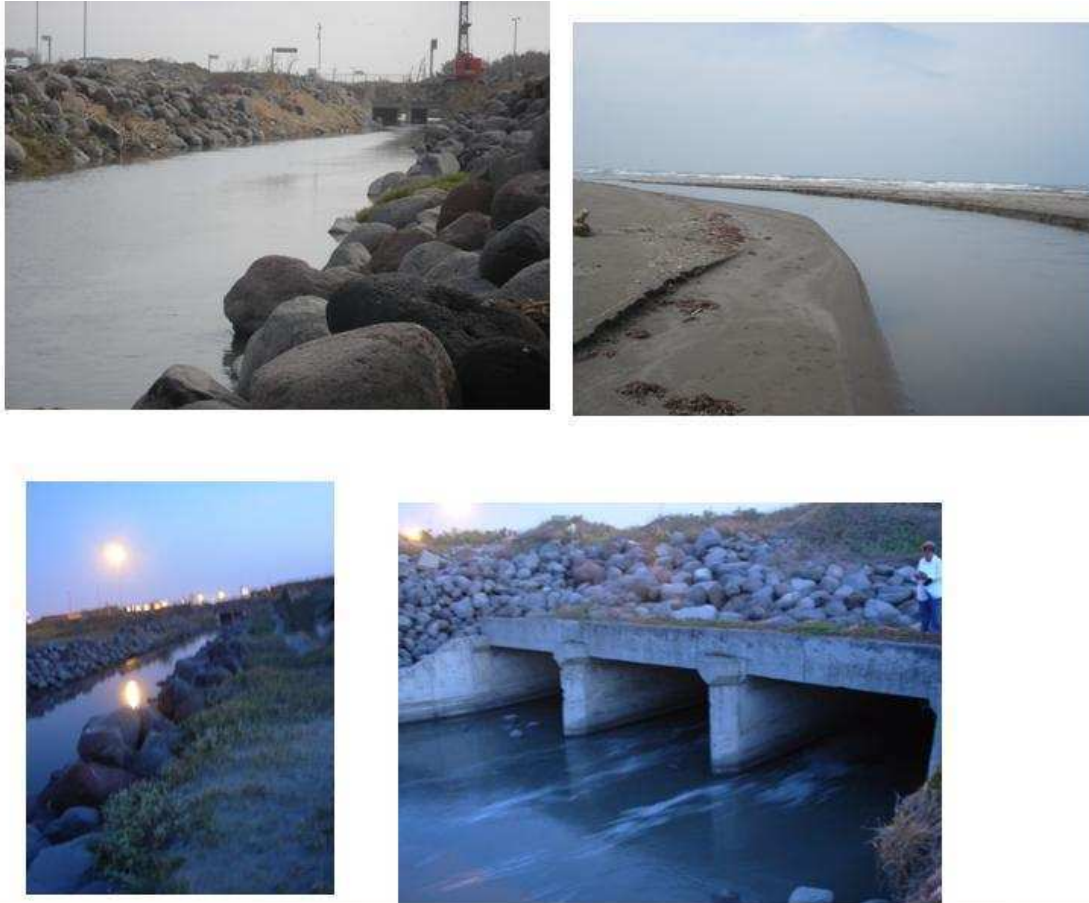
Figura 1.5: Arroyo El Cable. Descarga ubicada en 19^{\circ}12'51'' N, 96^{\circ}09'37'' W. En este sitio se unen las descargas tratadas y no tratadas, con un gasto total aprox. de 1700 l/s. La mayor parte de las aguas residuales de la ciudad descargan en este sitio.
