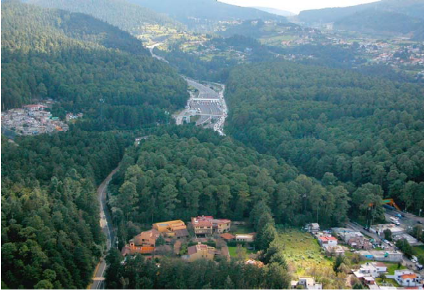
Imagen 2.3 Caseta de cobro de la autopista México-Toluca.
