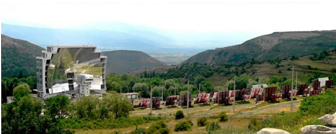
Figura 1.5: Horno solar de Odeillo, Francia.
