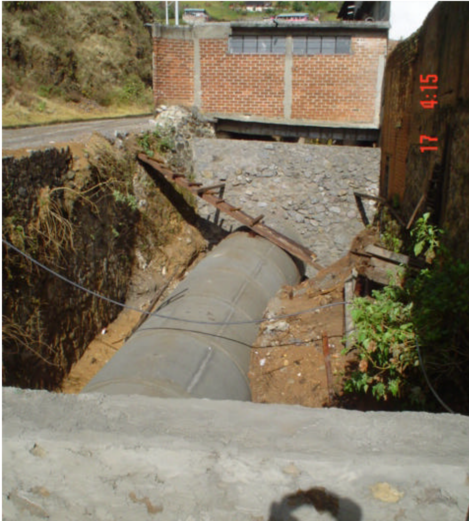
El ayuntamiento lleva a cabo la entubación del río Catingón lesionando gravemente uno de los principales valores históricos y urbanísticos, pues este elemento sirvió como límite en el lado poniente, a los primeros solares en su época de fundación.
