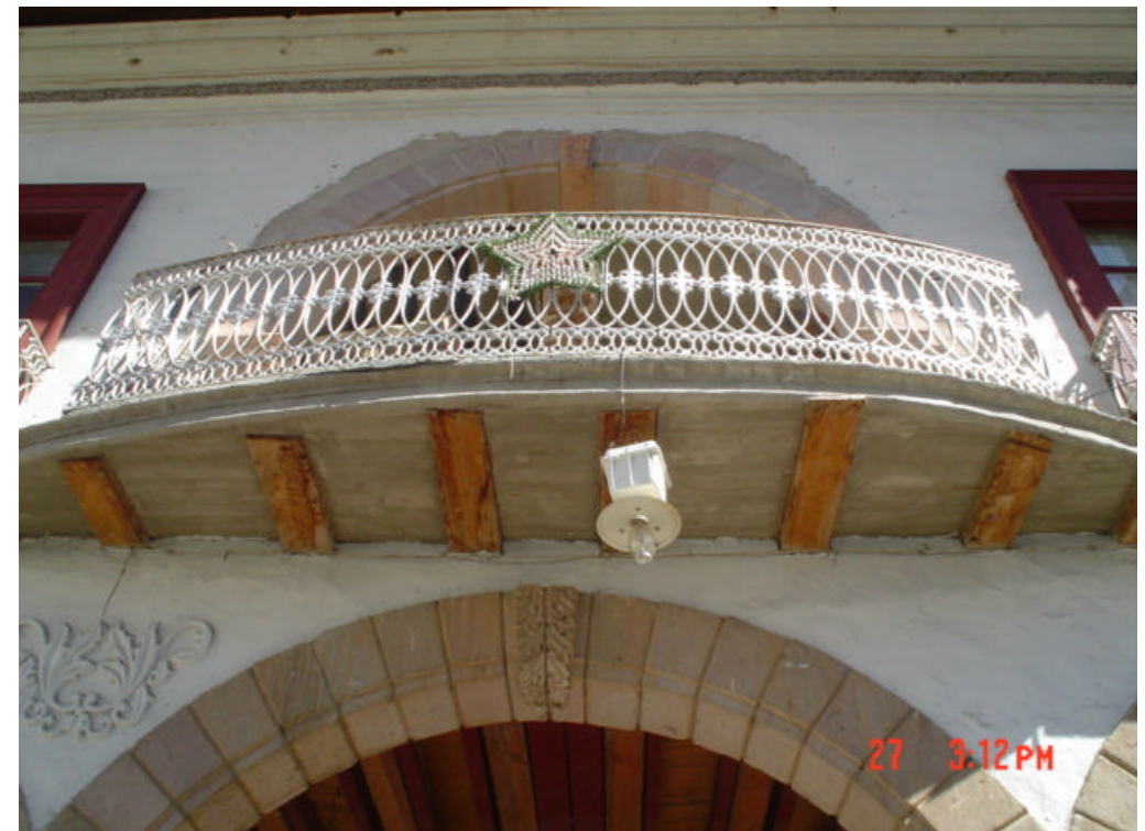
Alteración conceptual en la fachada principal. Nótese la presencia de materiales ajenos a los tradicionales
