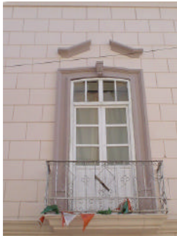
ventana de madera con vidrio, repisa de cantera con herrería de fierro colado
