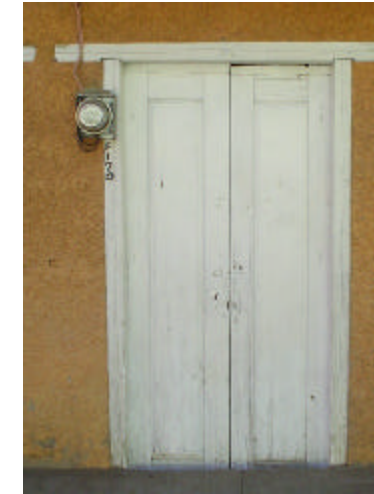
puerta sencilla de madera con marco sencillo de madera pintado con vinílica
