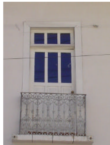
ventana de madera con vidrio, marco sencillo de madera, repisa de concreto y herrería de fierro colado.
