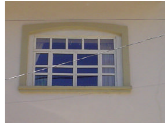
ventana de madera con vidrio y marco de aplanado a base de cal arena pintado con vinílica
