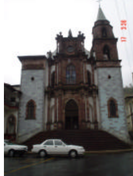
cubierta de lámina de zinc en torre de la parroquia de San Simón.
