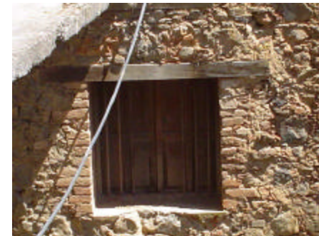
ventana de madera con protección de tubulares remachados, con dintel de madera
