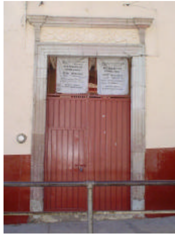
puerta de fierro estructural con marco moldurado de cantera con tapa
