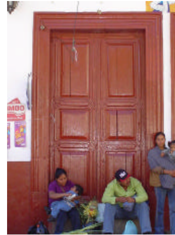
puerta de madera moldurada con marco de cantera moldurado
