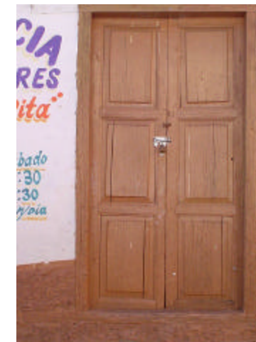
puerta moldurada de madera, con marco sencillo de madera pintado con vinílica
