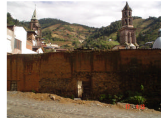
muro mixto de piedra de la región y adobe asentado con agualodo, acabado aparente
