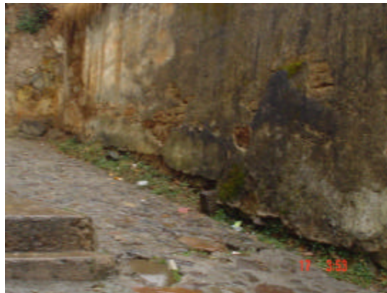
La calle de Rayón, presenta el empedrado original, reparado recientemente con el mismo material
