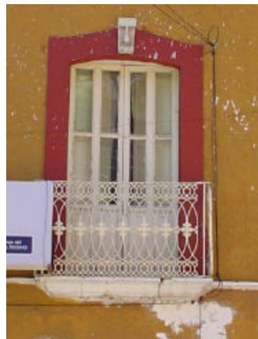
ventana de madera con vidrio, marco aplanado de cal arena, con clave y herrería de fierro colado
