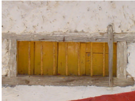
Ventana de madera con protección de barrotes de hierro Colado, con marco sencillo de madera
