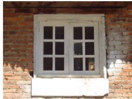
ventana de madera con vidrio, con marco moldurado de madera pintado con vinilica
