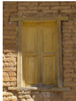
ventanas de madera moldurada con marco sencillo
