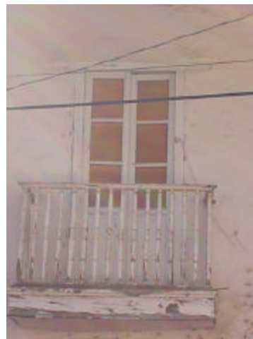
ventana de madera con vidrio, repisa y balcón de madera
