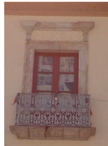
ventana balcón con marco de cantera moldurada, repisa de cantera y herrería de fierro colado
