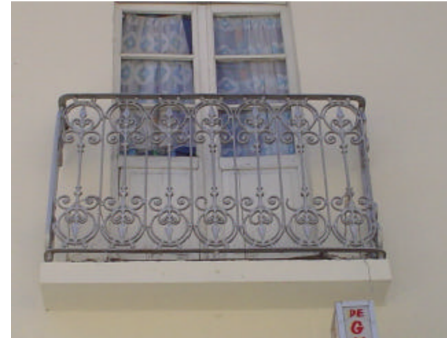
ventana de madera con vidrio, sin marco, repisa de concreto y herrería de fierro colado.
