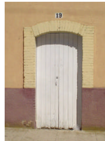
puerta sencilla de madera con marco de tabique rojo con dintel escarzano
