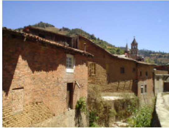
Muro de tabique de barro rojo recocido de 6x 14x 24 cm Combinado en algunas de sus partes con adobe
