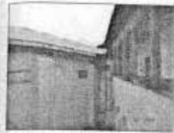
(F1) VISTA PATIO Y CORREDOR PONIENTE
