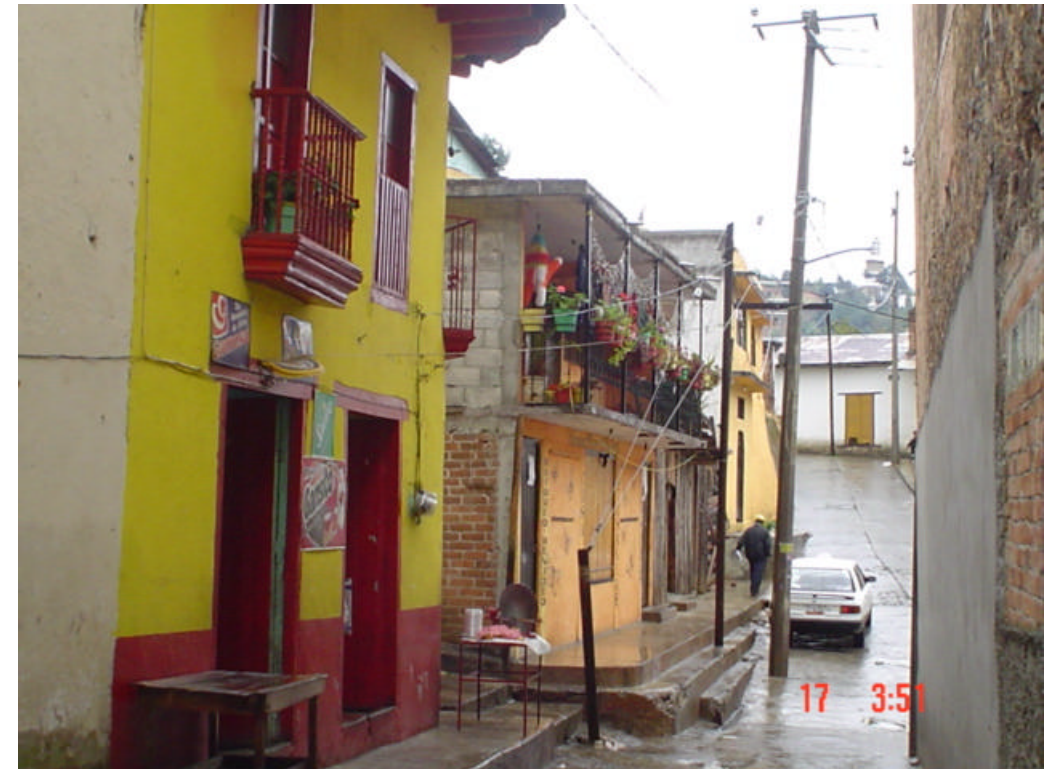
Sustitución de estructuras de madera a base de vigas, morillos y cintas de madera por losas de concreto
