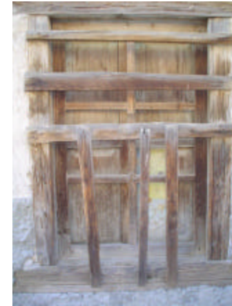
ventana de madera tablereada con protección de barrotes de madera
