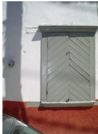
ventana de madera con hojas de protección y marco moldurado de madera
