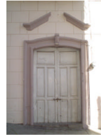
puerta de madera con marco aplanado a base de cal arena con clave y frontón cortado
