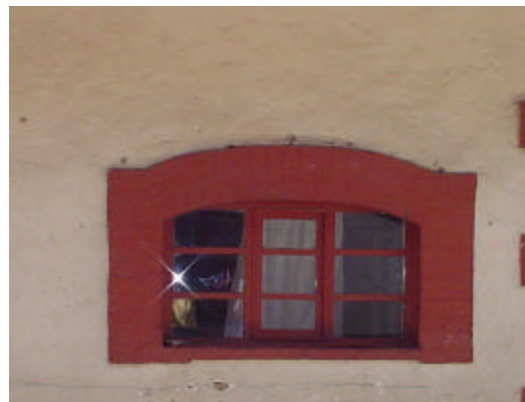
ventana de madera con vidrio y marco de tabique rojo con dintel escarzano pintado con vinilica
