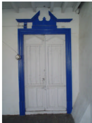
puerta de madera moldurada con marco moldurado de madera con remate mixtilíneo
