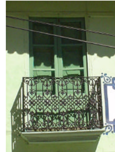
ventanas de madera con vidrio, ciegos y marcos sencillo de madera, repisa de madera con herrería de fierro forjado
