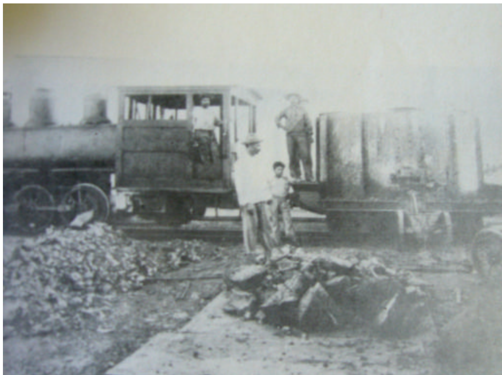
Una de las locomotoras del ferrocarril, arrastrando los picheles que portaban la escoria que se vaciaba en los moldes para la construcción del puerto. Juan Manuel Romero Gil, El Boleo, Santa Rosalía, B.C.S.
