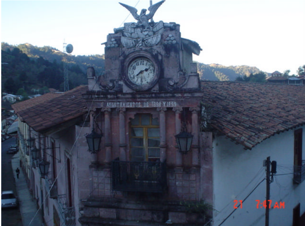
Fachada norte que presenta el tratamiento de pauncoupe delatando la eliminación de alero del siglo XVIII
