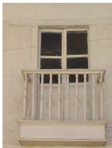
ventana de madera con vidrio y balcón de madera
