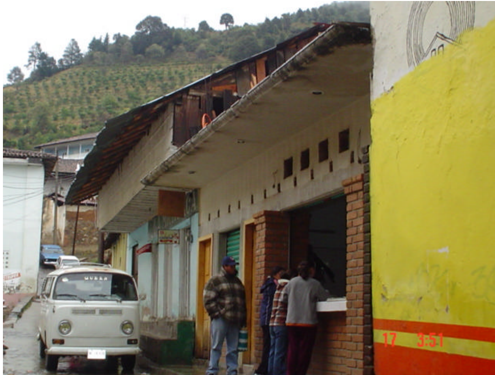
Sustitución de materiales tradicionales como el tabique rojo recocido y adobe por block de tabicón
