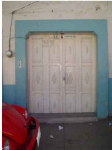
portón de madera moldurado con marco aplanado de cemento con reminiscencia art-decó
