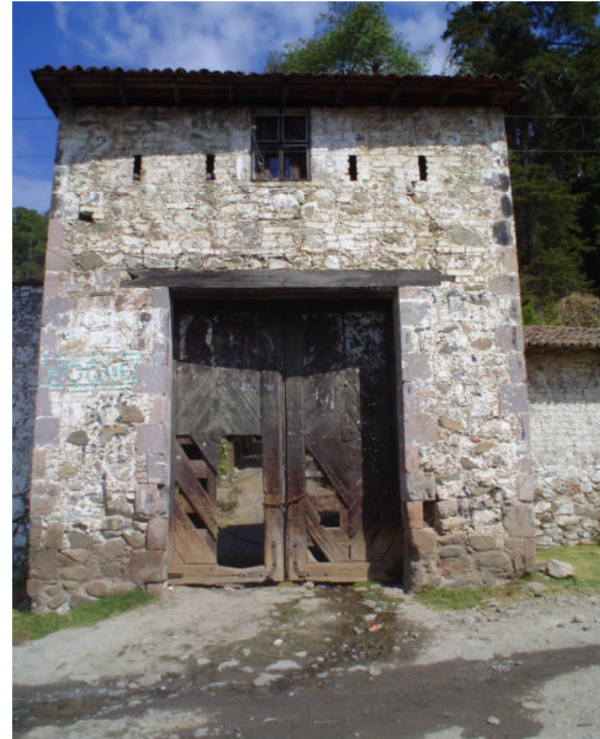
La puerta principal tenía forma de torre de vigía y poseía ventanas troneras, para proteger el complejo de los posibles robos e intrusos
