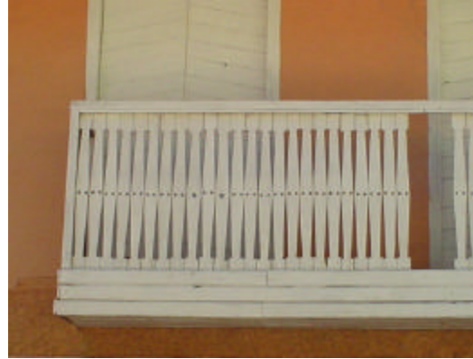
balcón corrido de madera con balastras de inspiración neoclásica, acabado con pintura vinílica
