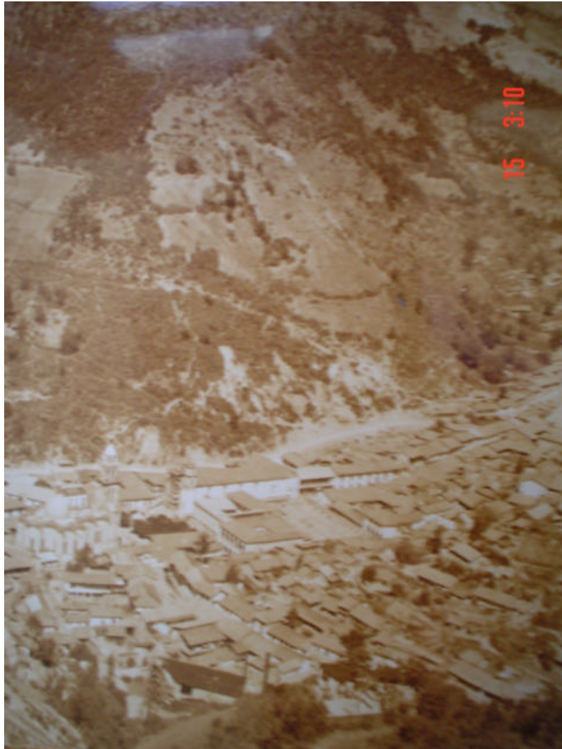
Fotografía del mineral de Angangueo hacia 1940, nótese la disminución de casas sobre las cañadas sobre el lado poniente.
