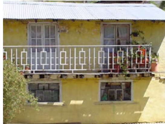
balcón corrido de madera pintado con vinílica
