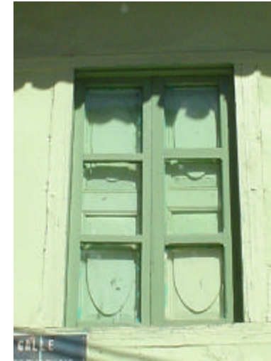
ventana de madera con marco sencillo de madera y vidrios artesanales con ciegos de madera moldurados
