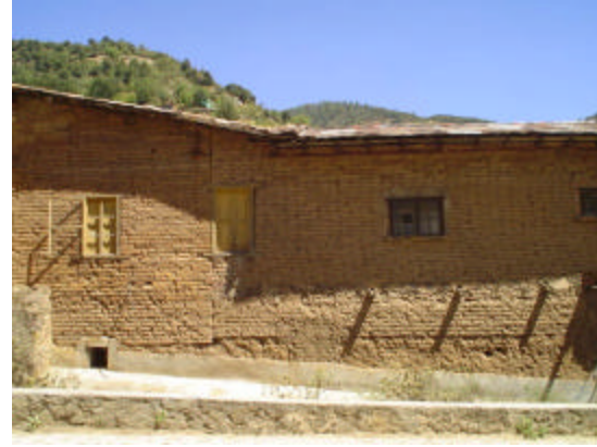
muro mixto de adobe reforzado con raíces naturales de aproximadas de 20x 40x 60x acabado aparente
