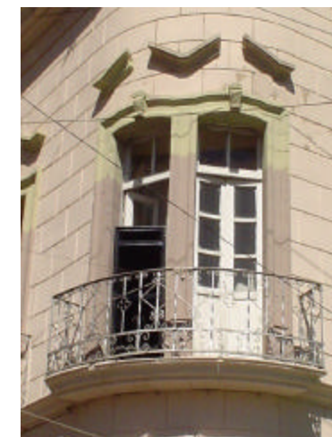
ventana pareada de madera, marcos aplanados a base de cal arena, tapa con frontón cortado y herrería forjada
