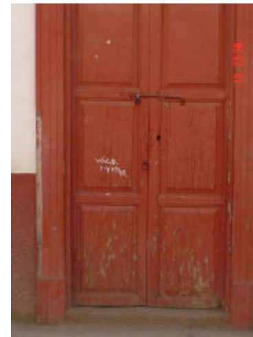
puerta de madera moldurada con marco moldurado de madera
