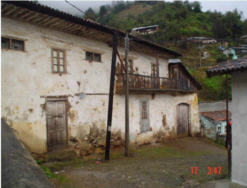
Arquitectura tradicional del Real de Minas, fabricada con adobe, madera y teja de barro
