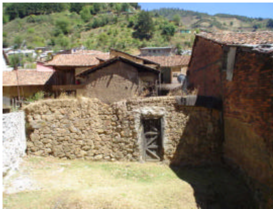
Muro de trascorral fabricado con piedra de la región asentado con agualodo, acabado aparente
