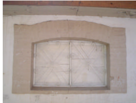
ventana de madera con protección de fierro laminado con marco de tabique rojo recocado pintado con vinílica
