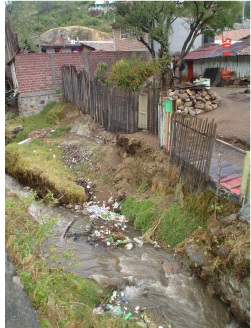
Las aguas negras desembocan en el río Catingón y grandes cantidades de basura son depositadas sobre éste, contaminándolo gravemente
