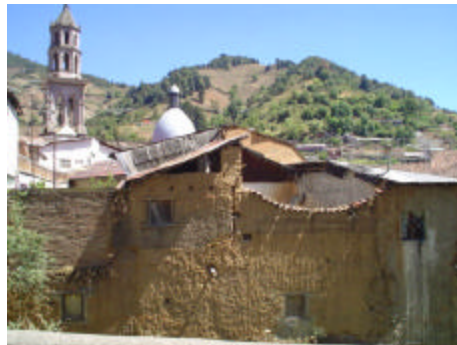
cubierta de lámina de zinc en cúpula del templo de la Concepción
