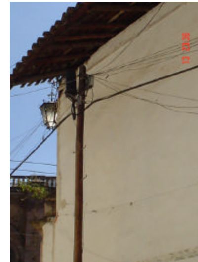
Armadura de morillos y cintas de madera
