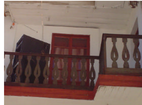
balcón de madera de la Parroquia de San Simón de mediados del siglo XIX, de inspiración neogótica acabado con pintura vinílica.
