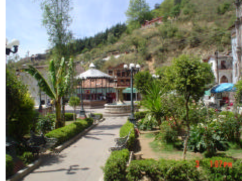
cubierta de lámina de zinc en el kiosco del jardín Constitución
