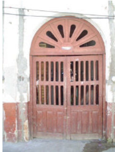
portón de madera moldurada con barrotos y cerramiento de 1/2 punto
