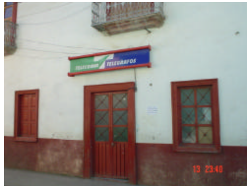
letrero de lámina con perfil estructural
