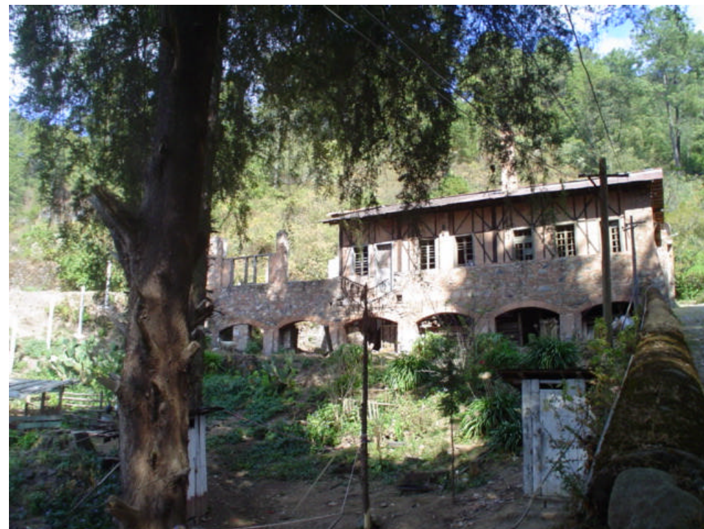
Taller de reparación de maquinaria de la hacienda de beneficio de “Trojes” a finales del siglo XIX.
