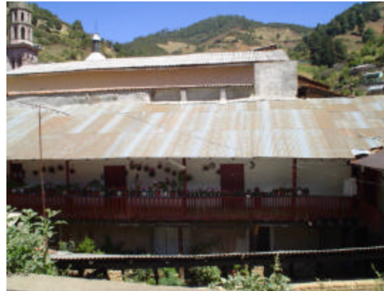
cubierta de lámina de zinc sobre armadura de madera a base de morillos y cintas
