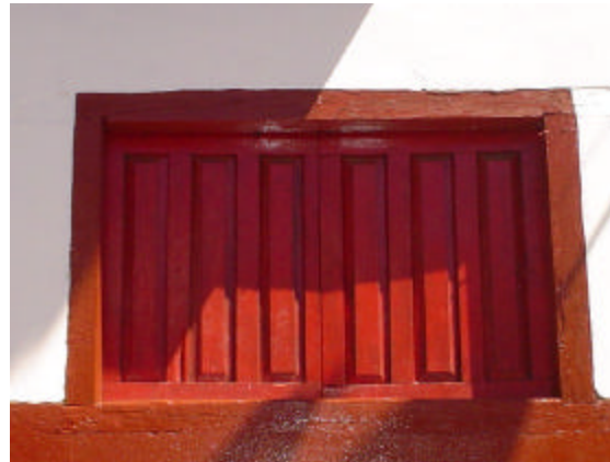
ventana de madera moldurada con marco sencillo de madera, pintado con vinílica en color rojo
