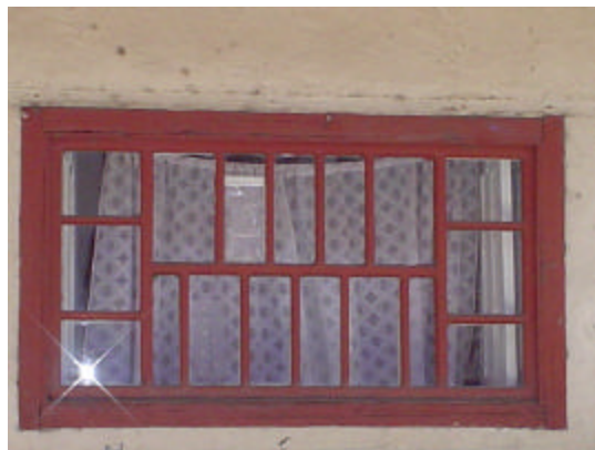
ventana de madera con vidrio y marco de madera
