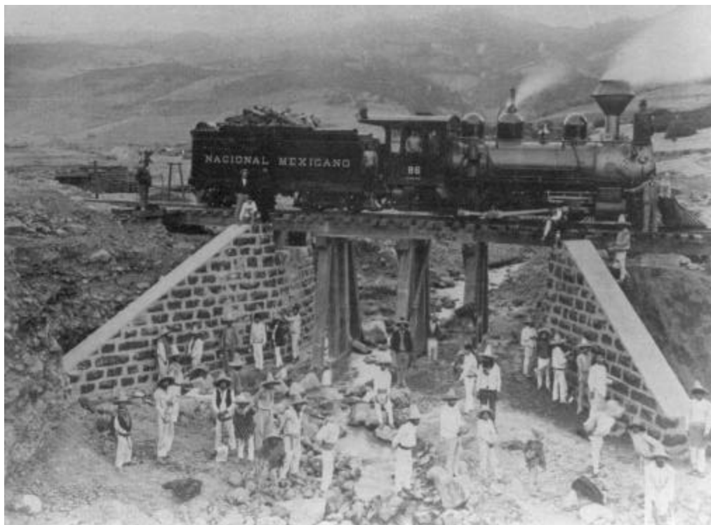
Construcción del puente para el paso del ferrocarril, hacia 1897
