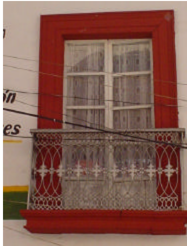
ventana de madera con vidrio, repisa de cantera y herrería de fierro forjado
