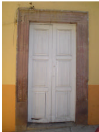
Puerta de madera con marco de cantera moldurado
