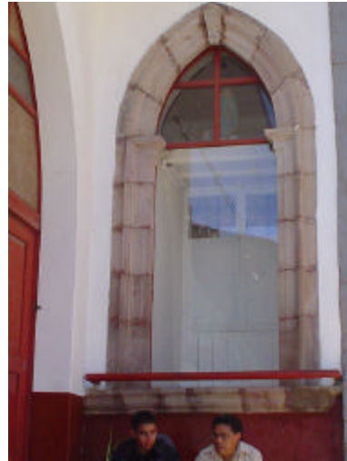
ventana de madera con vidrio translúcido ( parroquia de San Simón ) marco moldurado de cantera de la región de estilo neogótico
