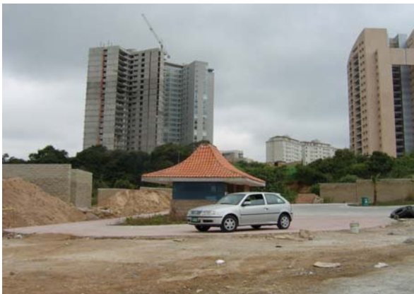
CASETA DE ACCESO A "LAS PLAZAS"
