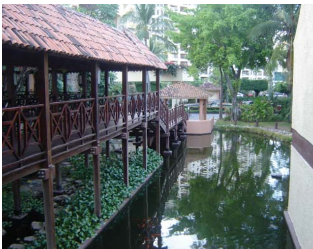
PUENTE DE ACCESO A "MIKADO"
