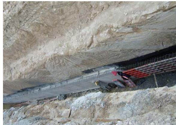
AVANCE DE DUCTO SUBTERRANEO DE INSTALACIONES
