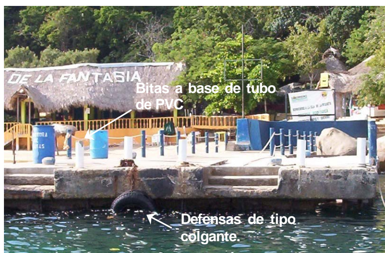
Figura. 3.5.- Vista frontal del muelle
