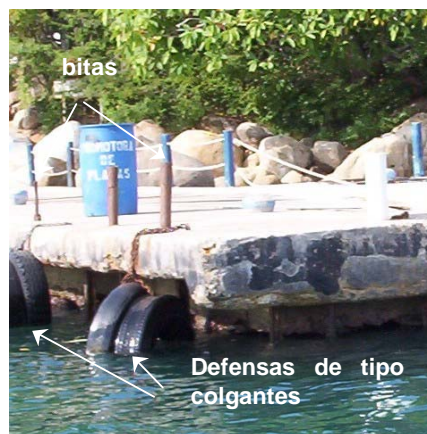
Figura. 3.7.- Elementos de protección del muelle
