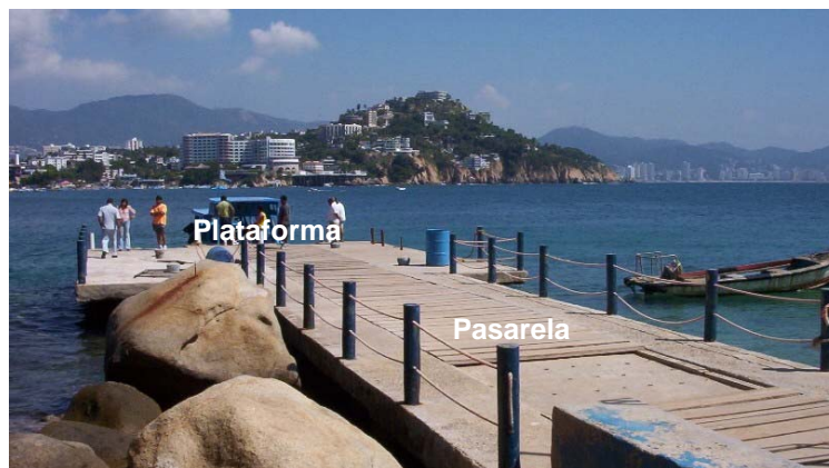
Figura. 3.4.- Vista del muelle existente en la Roqueta
