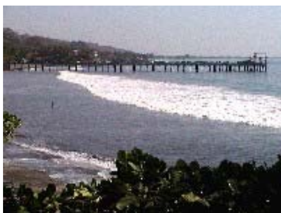
Figura 2.8.- Imagen de muelle apoyado en pilas.
