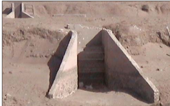
Fig. 1.6 Compuertas de entrada y salida
