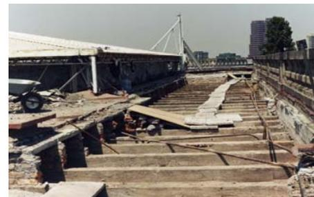
Detalle de trabajos en cubierta del Alcázar y deterioros en balaustrada
