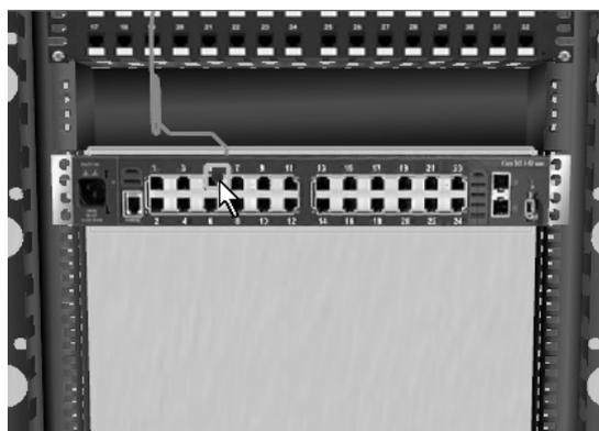
**Figura 4.79.** Colocación de terminal en el switch.
