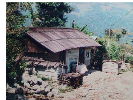
V3.- Con techo de lámina de cartón o de zinc, muros de madera o cartón y piso natural.
