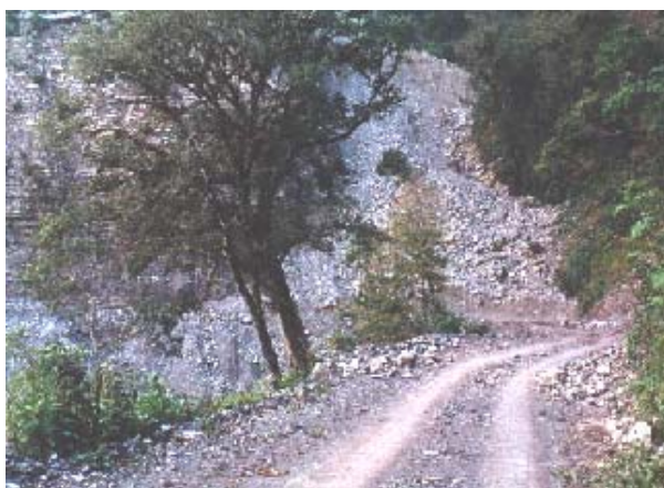
(Izq.) Camino Tlacuilotepec-Cuautepec: este tramo es uno de los más peligrosos de la región, el tipo de suelo arenoso provoca periódicamente fuertes deslizamientos que en varias ocasiones cierran definitivamente el paso. Es un tramo de 350 metros. (Der.) Camino Tlacuilotepec-Cuaxtla: el medio de transporte más común es el caballo y de carga el burro o la mula, es por ello que no es conveniente que los caminos se pavimenten, de forma que conserven su aspecto rural.
