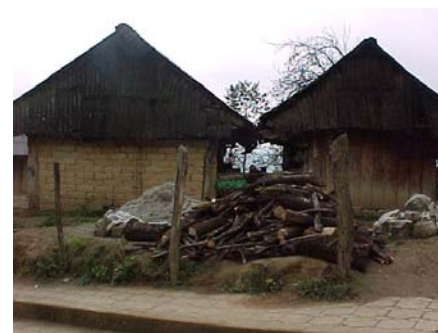
V2.- Con techumbre de madera y teja, muros de adobe y piedra con aplanado de cal y piso de tierra apisonada o con firme.
