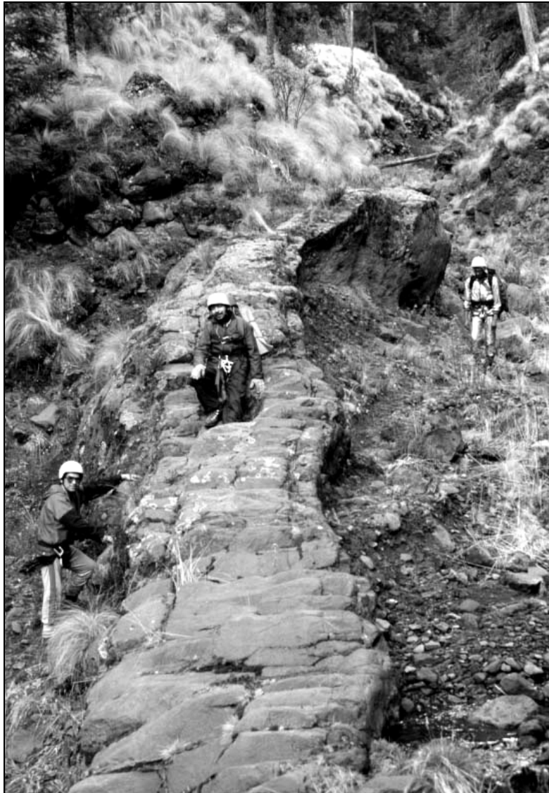
Figura 24: Dique en el fondo de la Barranca Nexpayantla.
