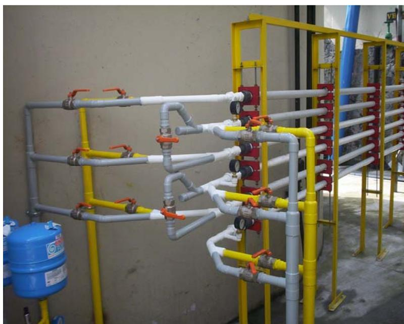
**Figura 0-3. Módulos tubulares de membranas**
