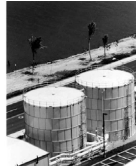
Figura 1.13 Fotografía de tanques con succión positiva.
