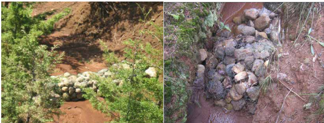
FIG. 10. Muros de Gavión localizados en cárcava de cañada derecha.
