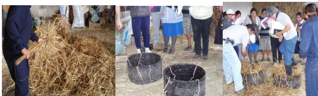
FIG. 5. Mezcla de ingredientes, molde (1/3 de tambo de 200 litros, compactado de mezcla.
