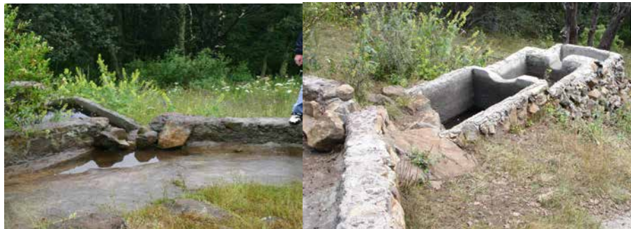
FIG. 14. Izquierda: captador Pico de víbora; Derecha: desarenadores Pico de víbora.
