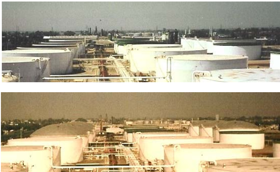
Figura 1.7 Adición de Domos a Tanques de Techo Flotante
