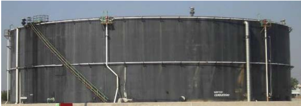
Figura 1.2 Tanque de Techo Fijo Cónico de 200 000 bbl (31,800 m 3 ), para Almacenamiento de Combustóleo.
