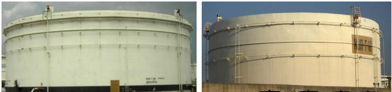
Figura 2.25. Tanques de Almacenamiento que Requieren Color Reflejante de la Radiación Solar
