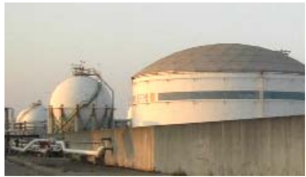
Figura B. Tanques de Almacenamiento
