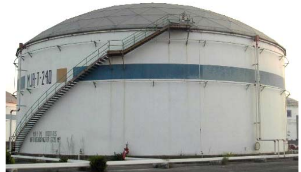
Figura 1.6b Tanque de 80 000 bbl (12 719 m 3 ) con Domo
