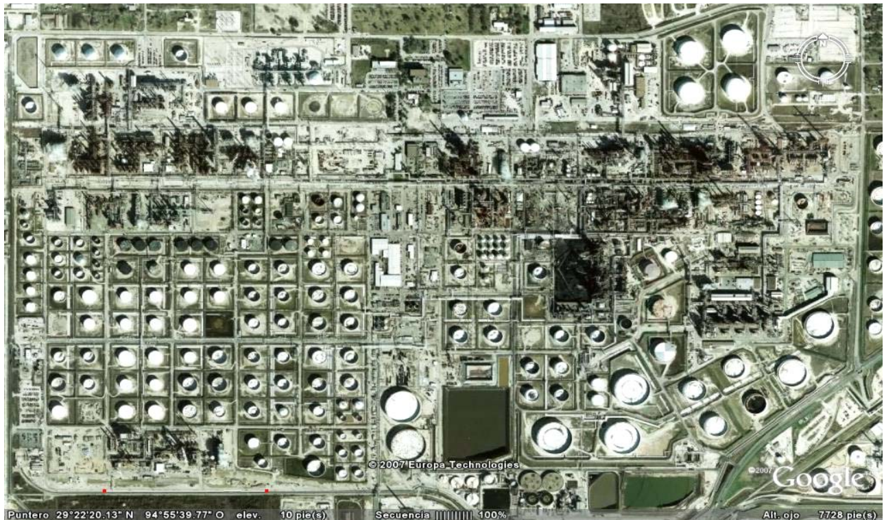
Figura C. Extensión de las Instalaciones de Almacenamiento en una Refinería de Petróleo.
