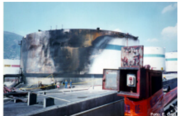
Figura 2.12 Tanques Dañados por Incendios
