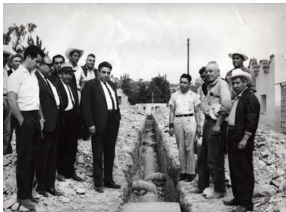
Imagen 22.- Introducción de drenaje en la cabecera municipal finales 50's.
