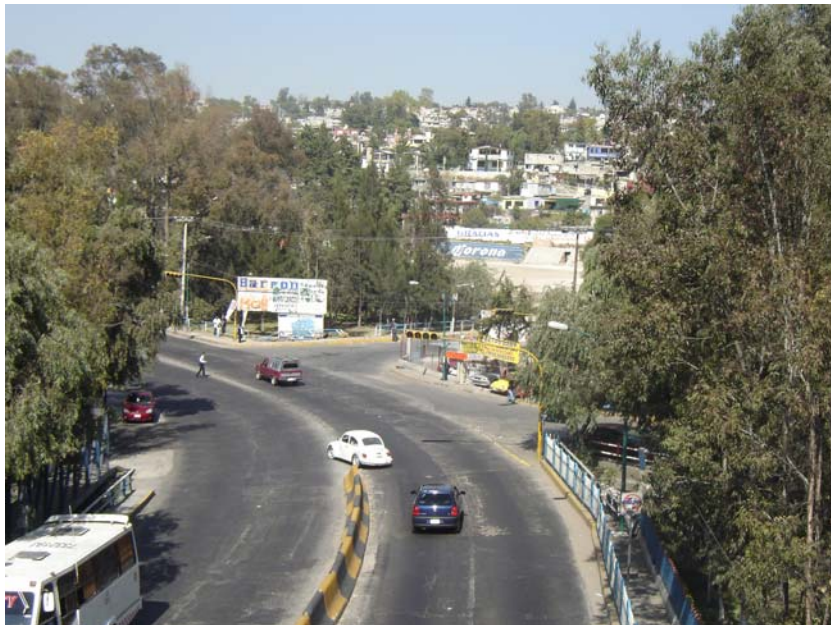
Imagen 72.- Falta de señalización en un crucero de alto riesgo a la entrada de la Col. Vicente Guerrero.
