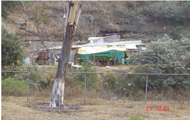
Imagen 57.- Casa construida con materiales de desecho “Col. Tráfico”
