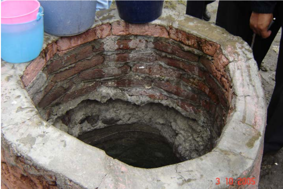
Imagen 52.- Pozo de dónde se abastecen del vital líquido algunos vecinos de la “Col. Los pocitos”.
