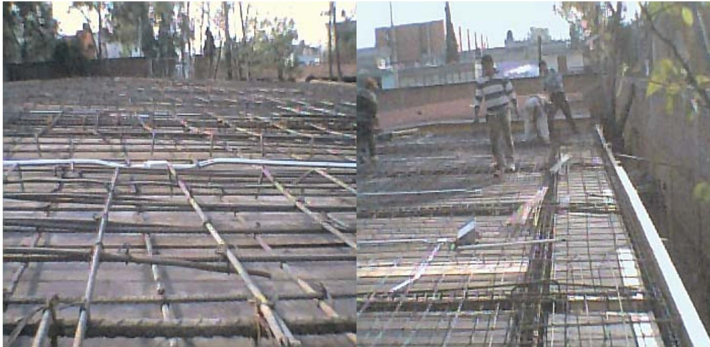
Previo al armado de la losa, se ha trazado la instalación eléctrica sobre la cimbra, ubicando las salidas de las lámparas y las bajadas de los contactos y apagadores, se fijaron las cajas cuadradas en lo que hemos definido previamente será su ubicación final, en este caso no se han utilizado codos por lo que todas las curvas se han hecho in situ con doblador. (Fig. 33)
