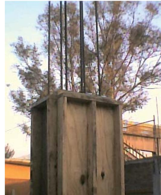
Fig. 18 Acero para anclaje de las columnas con la losa
