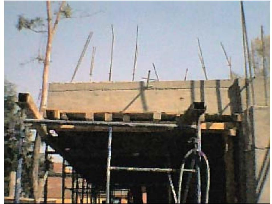
Fig. 34 Descimbra de trabes y losas
