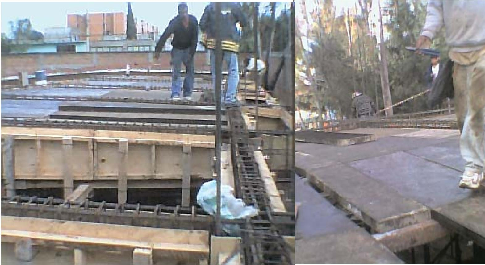
Fig. 30.- Los ajustes de la cimbra se realizan en el sitio y son la última parte de la cimbra, luego ya se inicia el armado de las losas.
