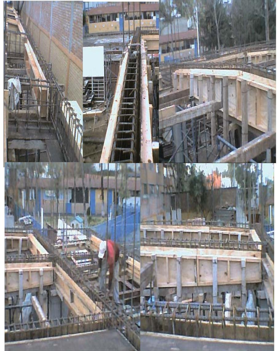
Una vez realizado el cimbrado de las trabes y su refuerzo, se fue colocando la cimbra de contacto para las losas, como la losa será a dos aguas, se observa la nivelación de las vigas con esta pendiente y se monta y aseguran los marcos de la cimbra, fabricada a base de marcos metálicos de ángulo de 2", refuerzos centrales
