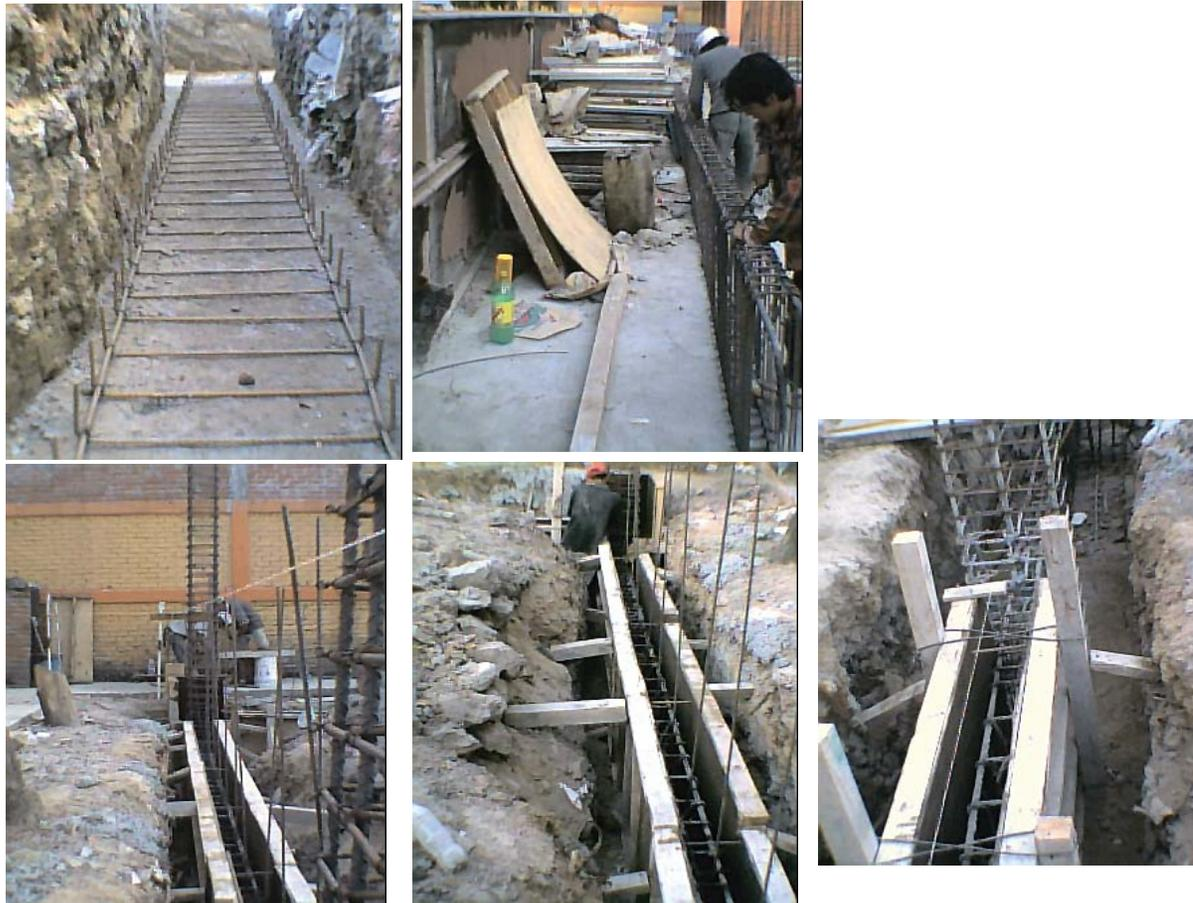
Fig. 13 Armado y cimbra de zapatas
