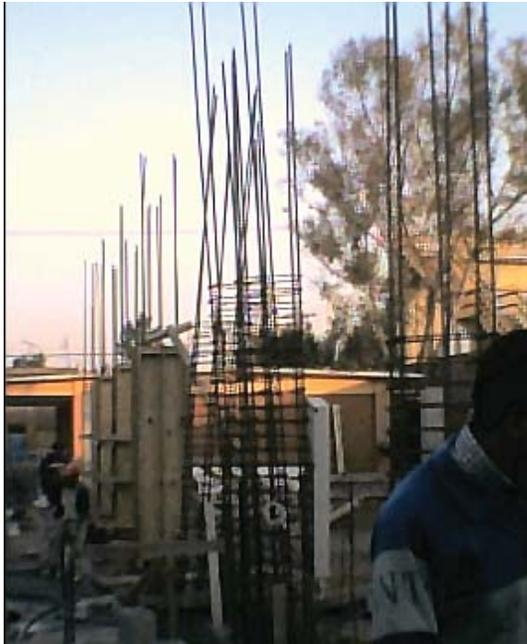
Fig. 17 Armado de columnas
