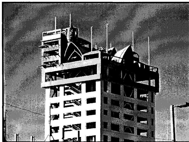
Negación de la arquitectura: Edificio de oficinas en Tijuana B.C. 2006
