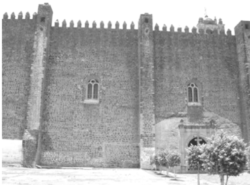
Figura 2.6 Contrafuertes adosados a los muros (Oaxtepec)
