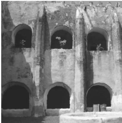
Figura 2.2 Claustro de contrafuertes (Atlatlahucan)
