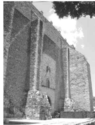
Figura 2.16 Contrafuertes del templo de Tlaquiltenango
