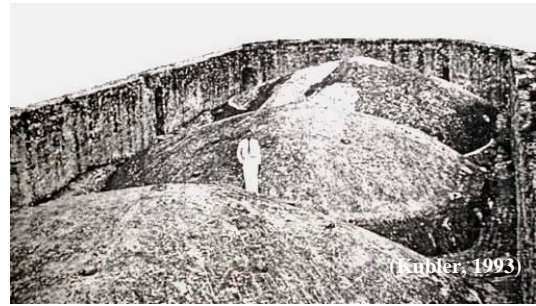
Figura 2.11 Extradós de bóveda de nervaduras en forma de domos (Acatzingo)
