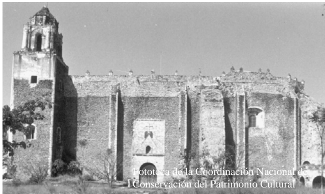
Figura 2.16 Contrafuertes del templo de Tlaquiltenango
