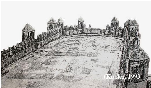
Figura 2.10 Extradós de bóveda de nervaduras cargada en sus riñones (Tula)
