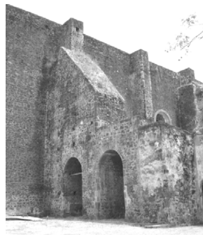
Figura 2.17 Contrafuertes del templo de Tlayacapan
