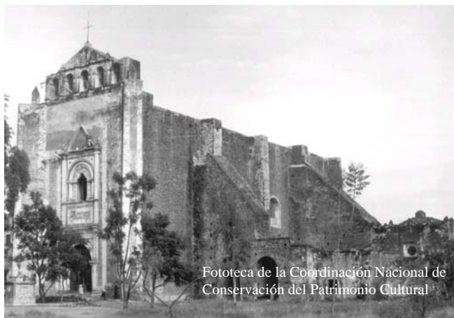
Figura 2.17 Contrafuertes del templo de Tlayacapan
