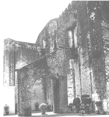
Figura 2.7 Contrafuerte botarel (Cuernavaca)
