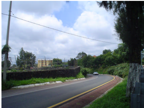
LADO NORTE INCORPORACIÓN A LA AUTOPISTA MÉXICO ACAPULCO
