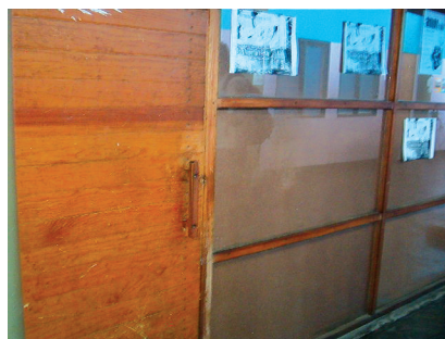
Sala de maestros en planta baja nave 1
