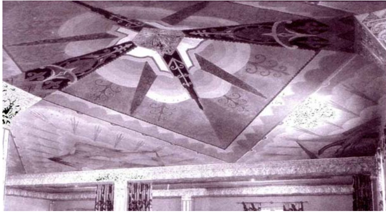
Fig. 14. Detalle del techo del salón comedor del hipódromo. 1929. Colección de la Biblioteca del Estado de California.
