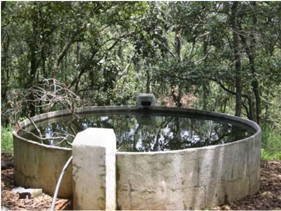
Figura 49. Cilindro almacenador de agua de lluvia
