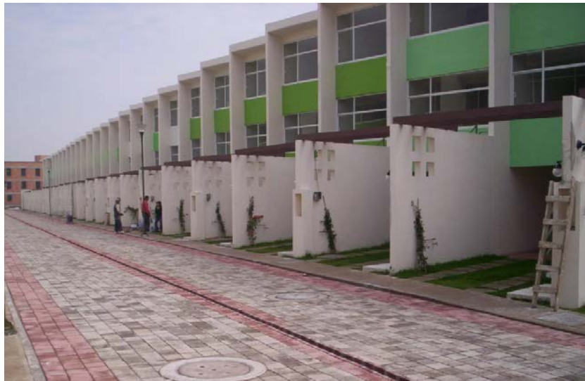
Fig. 23 Perspectiva de la Privada Álamo mostrando el diseño de áreas exteriores y pavimentos.
