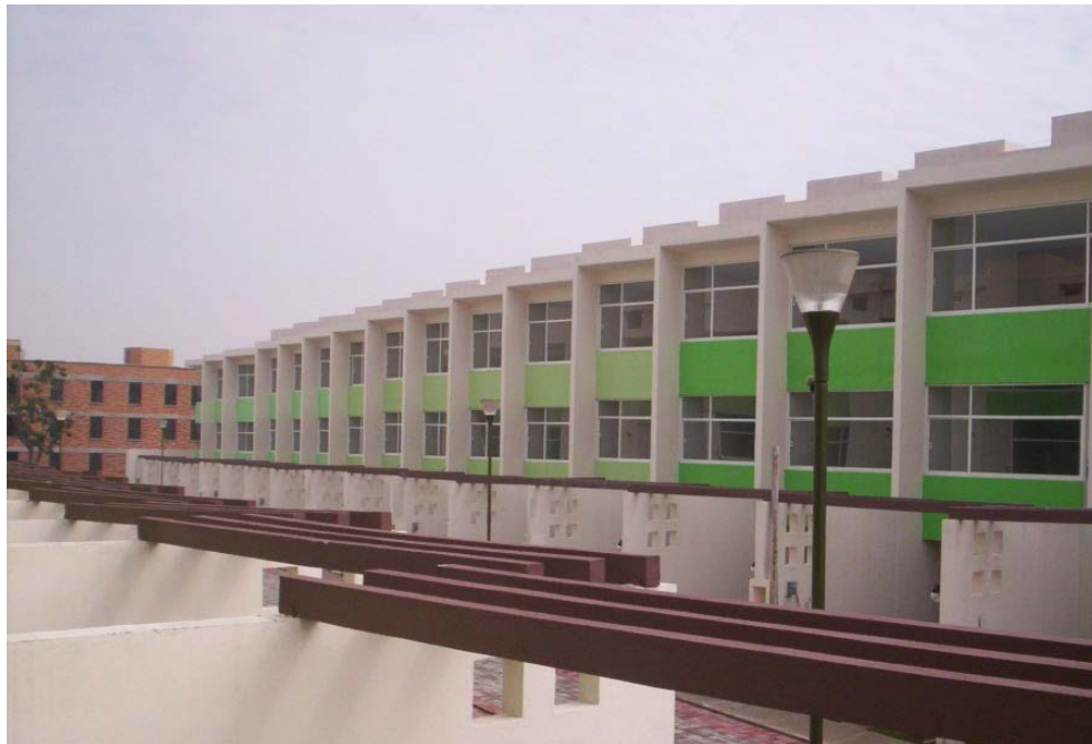
Fig. 24 Perspectiva desde el interior de una de las viviendas de la Privada Jacaranda.
