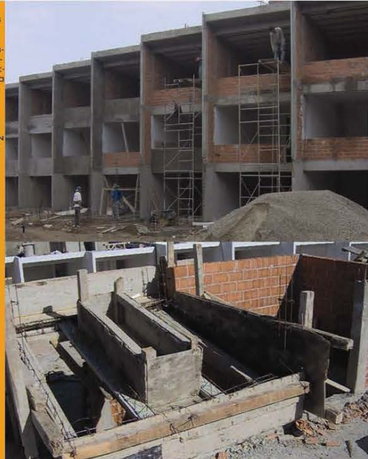
1 SISTEMA CONSTRUCTIVO DE VIGUETA Y BOVEDILLA CON LOSA ALIGERADA Y ESTRUCTURA DE MAMPOSTERÍA TIPO
