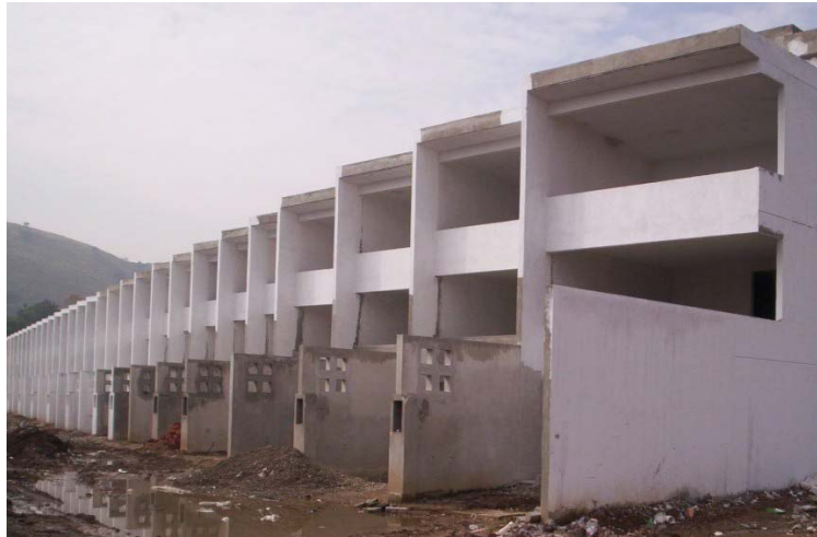
Fig. 20 Foto de la privada Álamo en proceso de obra al 14 de noviembre de 2006 que muestra el remate y voladizo de las últimas viviendas.
