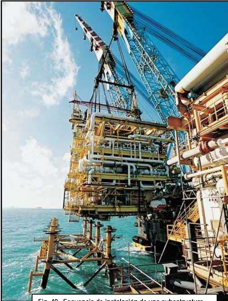
Fig. 40 Secuencia de instalación de una subestructura
