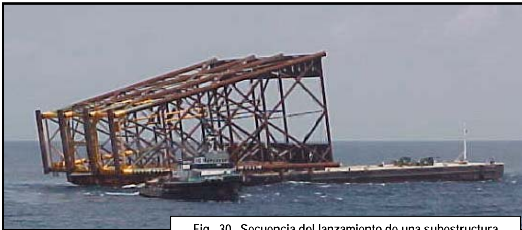
Fig. 30 Secuencia del lanzamiento de una subestructura
