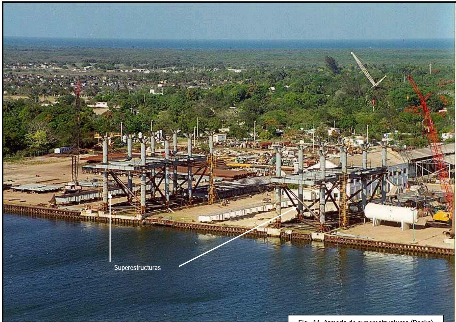
Fig. 14 Armado de superestructuras (Decks)
