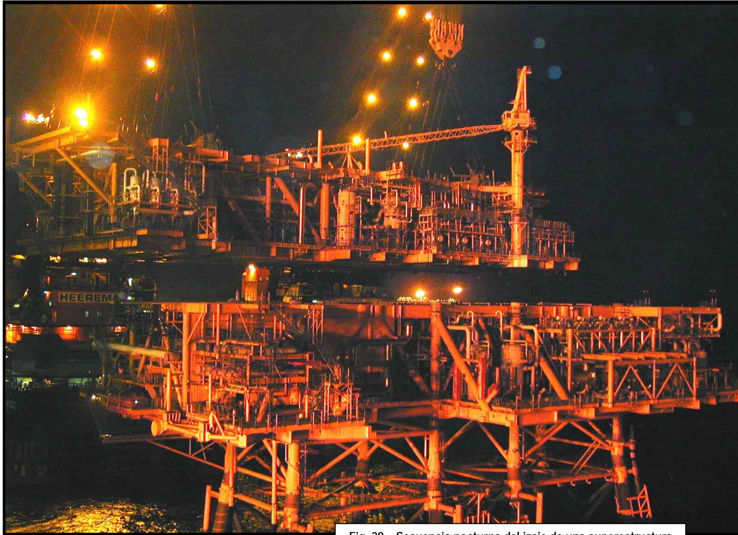
Fig. 39 Secuencia nocturna del izaje de una superestructura
