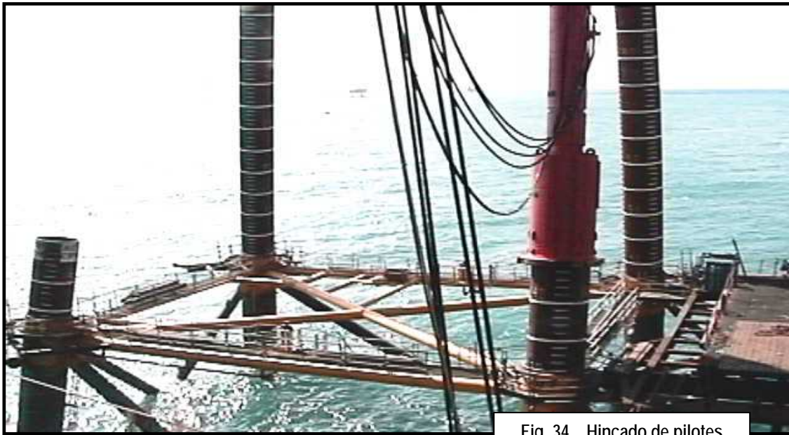
Fig. 34 Hincado de pilotes
