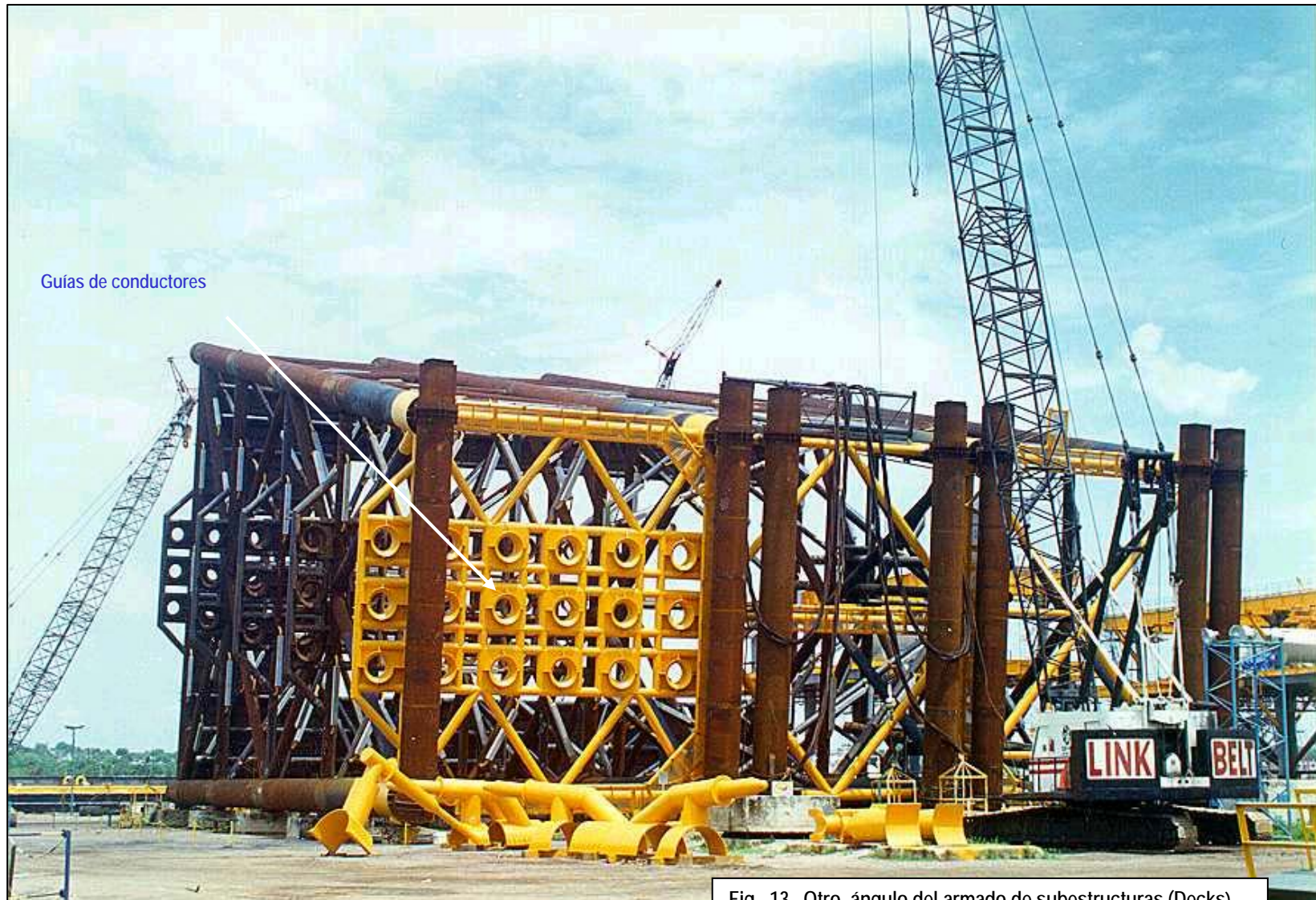
Fig. 13 Otro ángulo del armado de subestructuras (Decks)
