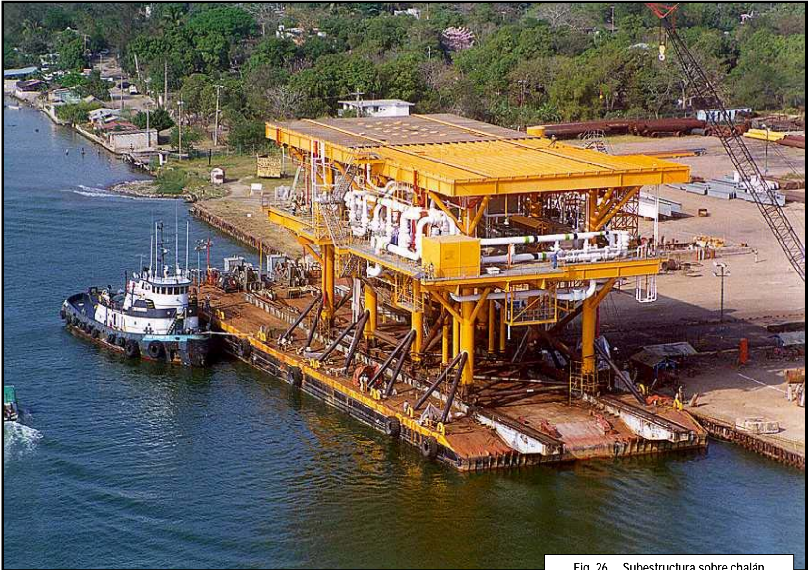
Fig. 26 Subestructura sobre chalán
