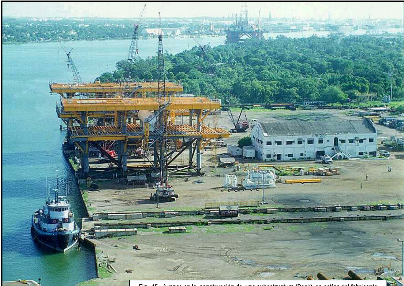
Fig. 15 Avance en la construcción de una subestructura (Deck) en patios del fabricante
