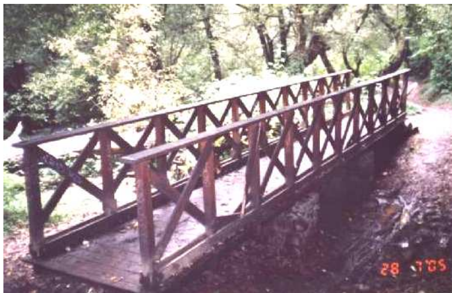
8. –Puente colocado a la altura del sendero que corre del Dinamo 2 al Dinamo 1, para librar un arroyo natural de temporal.
