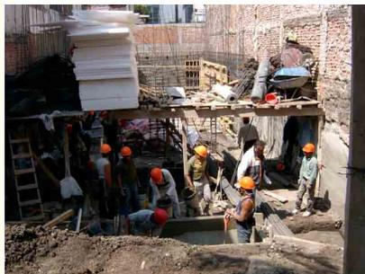
Armado y cimbrado de muros de colindancia. Colocación de concreto premezclado a bote en muros de colindancia.
