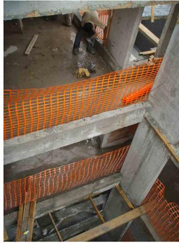
Colocación de malla de protección en vanos de ventanas que dan a cubo de iluminación.
