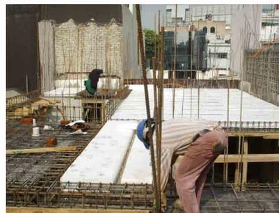
Colocación de vigueta y bovedilla y preparaciones eléctricas en losa
