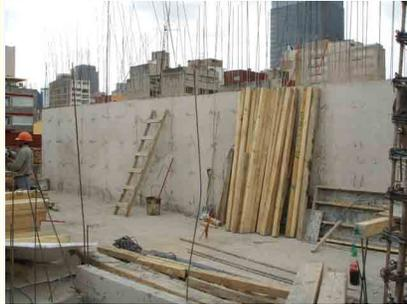
Descimbrado de muro de concreto.
