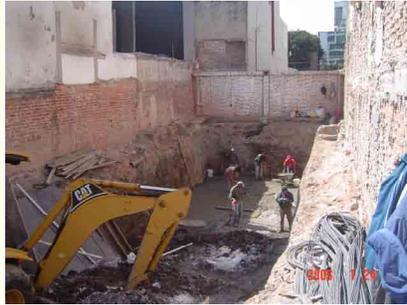
Excavación mecánica dejando taludes de protección a colindancia y colado de plantilla de desplante para la osa de cimentación.
