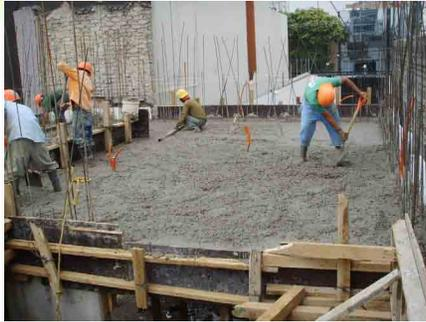
Colocación de concreto en losa con bomba estacionaria, se está pasando regla para dar nivel a la losa.
