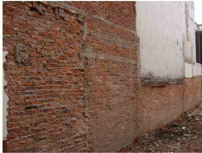
Colindancia izquierda del terreno, aquí se puede observar como los muros carecen de castillos y cerramientos por lo que la excavación tuvo que realizarse con mayor cuidado.
