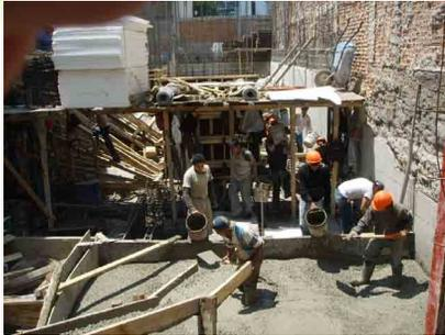
Fabricación de artesa para recibir concreto para colado de muros perimetrales.
