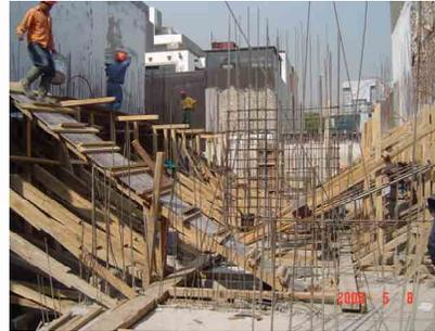
Cimbrado y colocación de concreto a bote en muros de colindancia.
