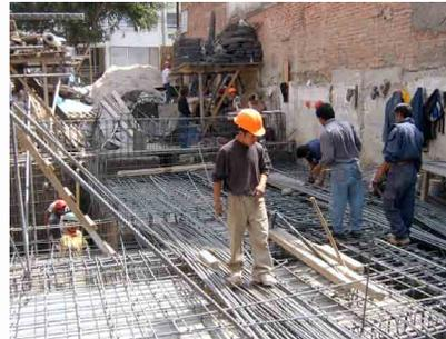
Armado de losa de cimentación y de muros perimetrales de cisterna.
