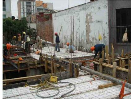
Colocación de vigueta y bovedilla en losa, con malla electro soldada para recibir concreto, preparaciones eléctricas en losa para luminarias y salidas para muros de tablaroca.
