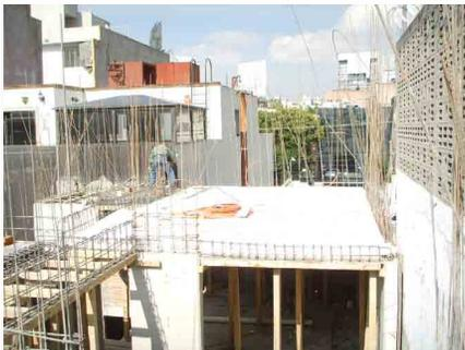
Cimbra de losa de tercer nivel y colocación de vigueta y bovedilla.
