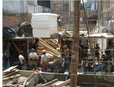
Armado y colocación de concreto a bote en muros perimetrales.
