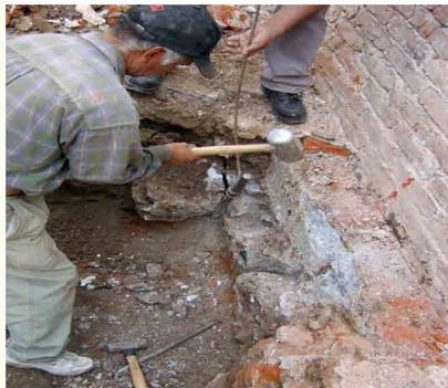
Excavación manual junto a colindancias para evitar dañar muro y cimientos.
