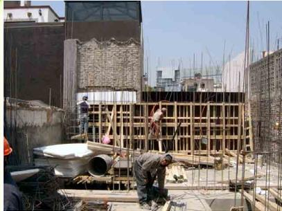
Armado y cimbrado de muros perimetrales, se dejaron preparaciones para las instalaciones eléctricas en los mismos.
