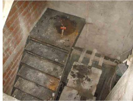
Colocación de escaleras principales de herrería a base de lamina anti derrapante
