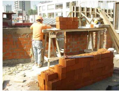
Levantamiento de muro de tabique estructural, colado de cadena intermedia en muro.
