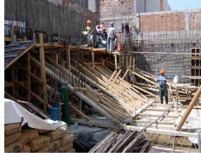
Se puede observar el cimbrado del muro perimetral, la colocación del concreto se realizó a bote para evitar que la presión del concreto fuera a dañar los muros colindantes.
