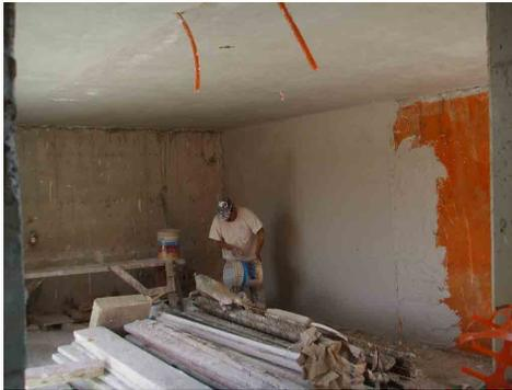
Aplicación de yeso en plafond y muros, se puede observar la utilización de pega yeso para adherir el yeso al concreto
