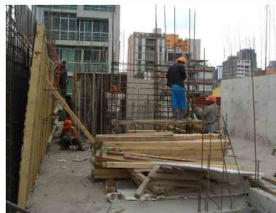
Habilitación y colocación de acero en armado de muros, habilitación y colocación de cimbra.
