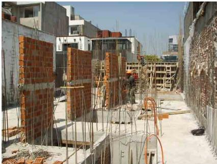
Levantamiento de muros de tabique estructural.
