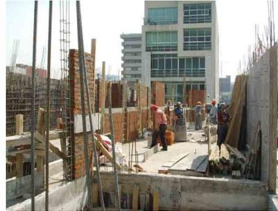
Levantamiento de muros de tabique rojo y de tabique estructural.
