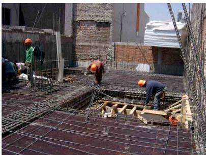
Armado de traves y de losa maciza. Cimbrado perimetral de traves en cubos de luz.
