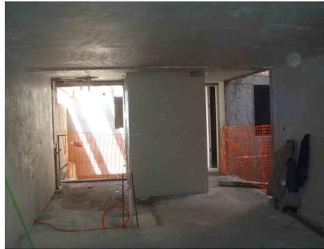
Aplicación de yeso en interiores y levantamiento de muros de tablaroca para divisiones internas de los departamentos.
