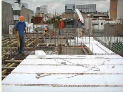
Colocación de vigueta y bovedilla en losa. También se están dejando preparaciones eléctricas en losa
