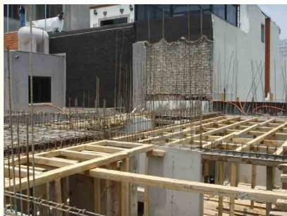
Cimbra para losa de vigueta y bovedilla y losas macizas en baños y cocinas
