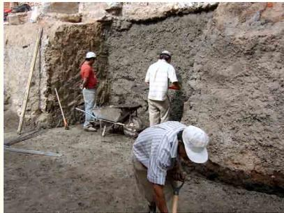
Recimentado a base de malla y repellado para evitar que se deslavara el muro de colindancia ya que no contaba con cimientos suficientes.
