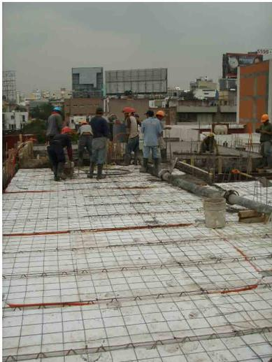
Colocación de concreto en losa de azotea, se puede observar la viga y bovedilla así como las preparaciones eléctricas en la losa.
