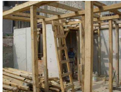
Cimbrado de losa de segundo nivel para recibir vigueta y bovedilla.
