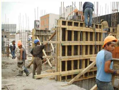
Colocación de concreto a bote en muro, también se observa el vibrado del concreto para evitar que queden huecos en el muro
