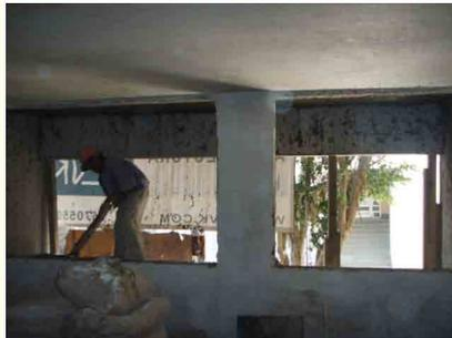
Aplicación de yeso en plafond, muros y emboquillado de vanos de ventanas
