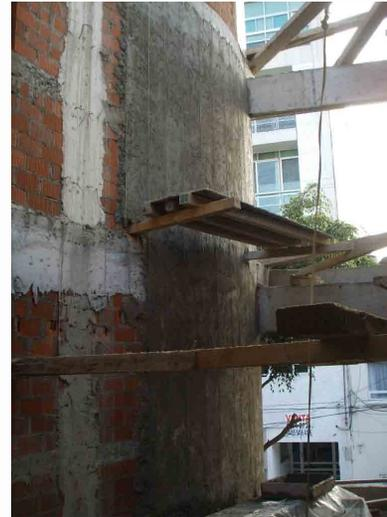
Repellado de muros de tabique en fachada.
