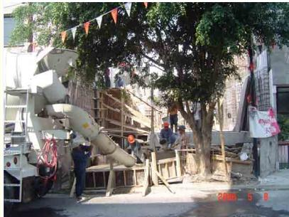
Vaciado de concreto premezclado en artesa para colado de muros.
