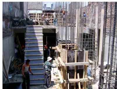
Se puede observar los frentes de trabajo de la obra. Armado y cimbrado de muros y columnas.
