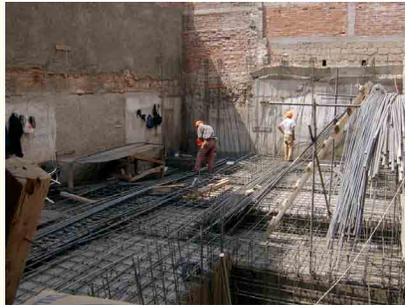
Armado de contra trabes y de losa corrida de cimentación
