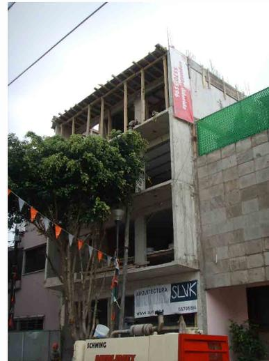
Vista de la fachada principal. Se puede observar la cimbra de la losa de azotea.
