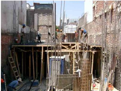
Cimbrado de losa de primer nivel hasta la mitad del predio para poder dar frentes de trabajo.
