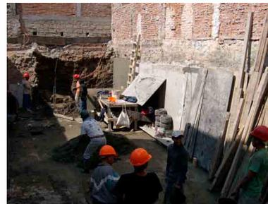
Vista del muro de colindancia con recimentación terminada. También se observa como se empieza a retirar talud de la colindancia posterior.
