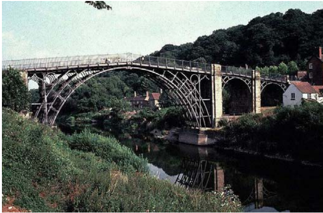
Fig. 2: El Puente de Coalbrookdale.
