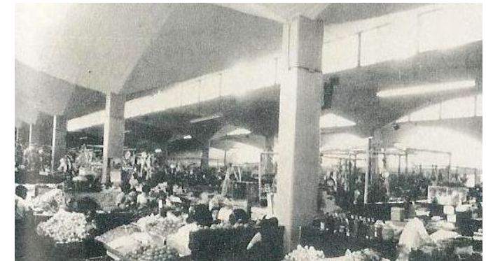
Fig. 24: Interior del Mercado de Coyoacán.
