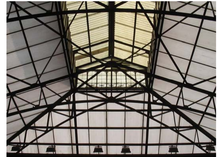
Fig. 35: Detalle cubierta del mercado.
