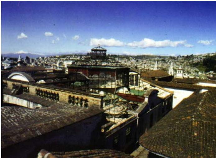
Fig. 53: Estructura implantada al interior de un inmueble, sobre las calles Benalcázar, Cuenca y Rocafuerte.
