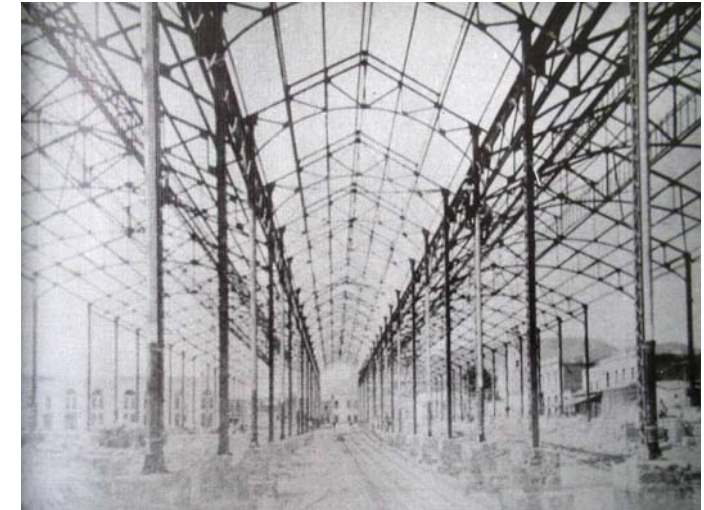
Fig. 33: Detalle estructura del mercado.
