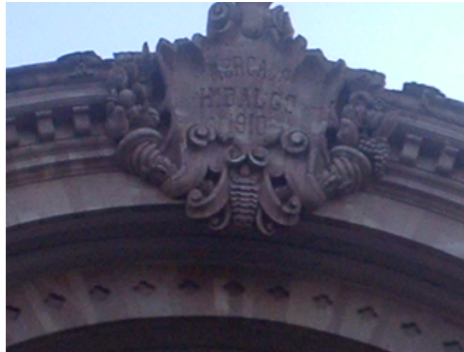
Fig. 39: Detalle de cantera rosa tallada.
