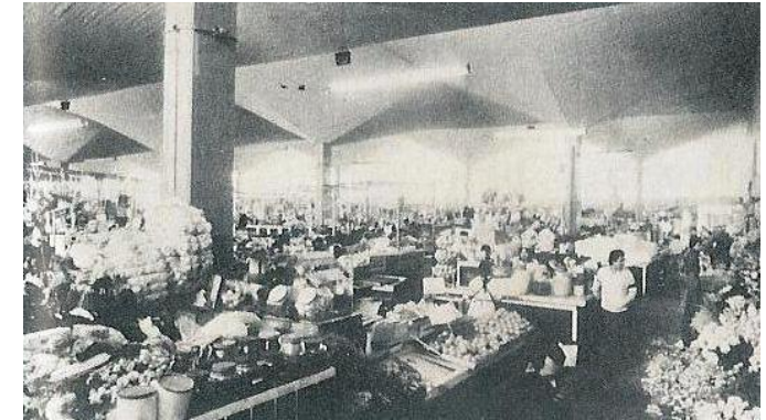
Fig. 23: Interior del Mercado de Coyoacán.
