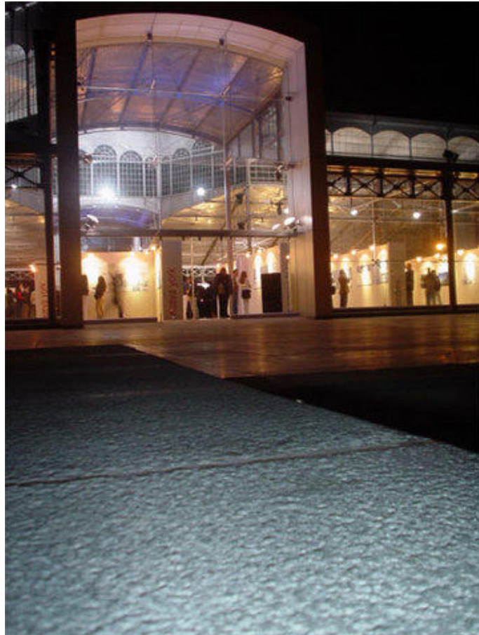
Fig.58: Detalle del acceso al edificio.
