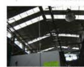
CUBIERTA METALICA EN EL PASADIZO DE PASAJES INTERIORES DEL MERCADO
