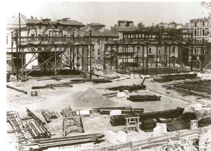
Fig. 18: Vista del exterior de Les Halles Centrales.
