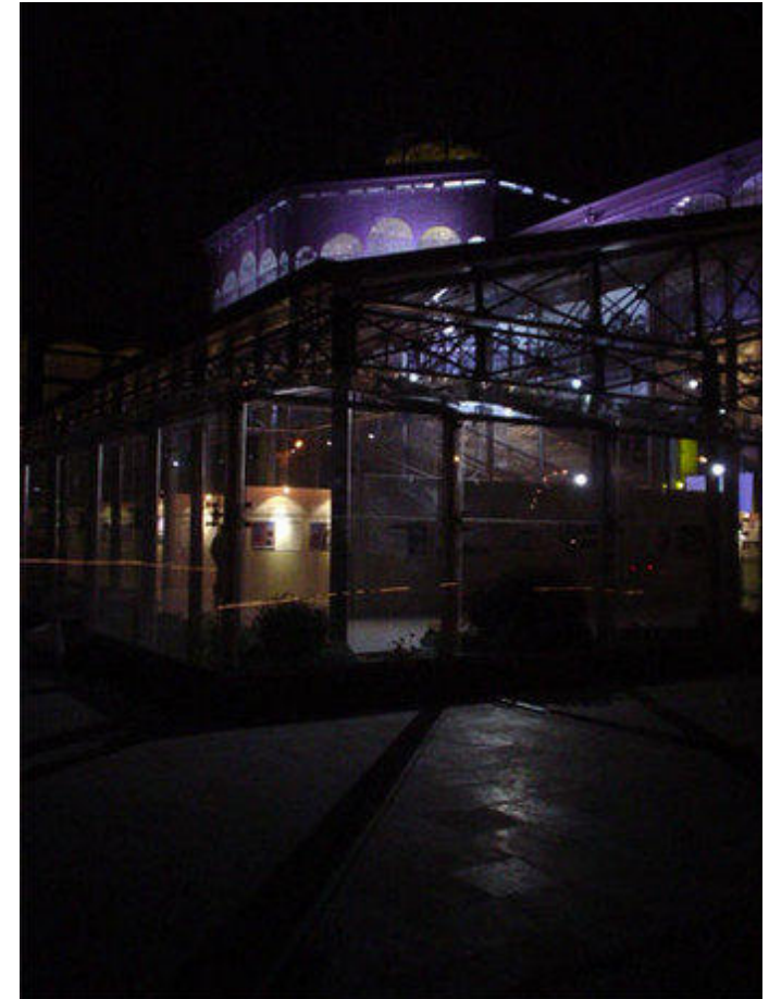
Fig.60: Vista desde el exterior.
