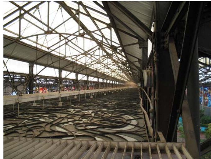
Fig. 34: Detalle cubierta del mercado.
