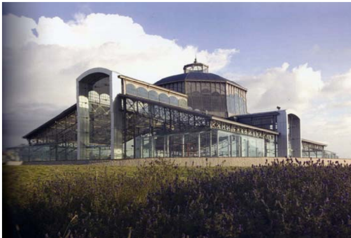
Fig.54: Estructura reimplantada en el Parque Itchimbia.
