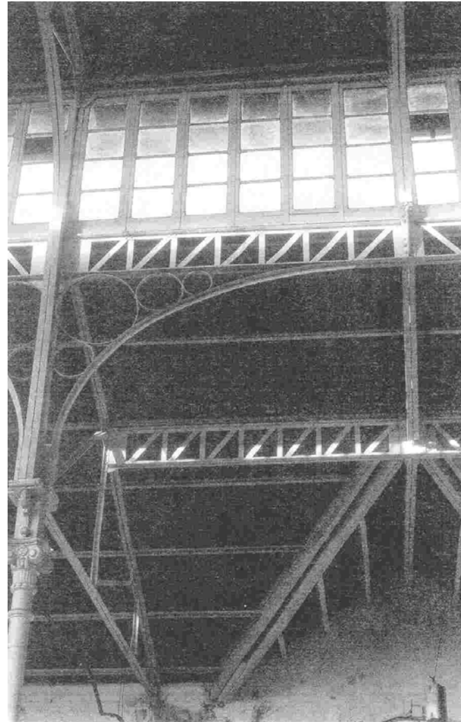
Fig. 25: Detalle de la estructura del Mercado.
