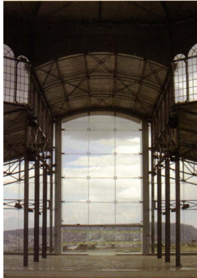
Fig.59: Detalle del interior del edificio.
