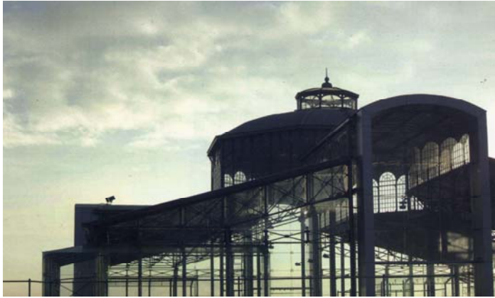
Fig.55: Detalle de la estructura.
