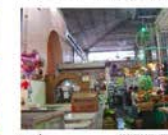
CUBIERTA METALICA INTERIORES DEL MERCADO
