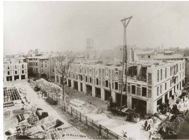
Fig. 17: Durante la construcción de Les Halles Centrales.
