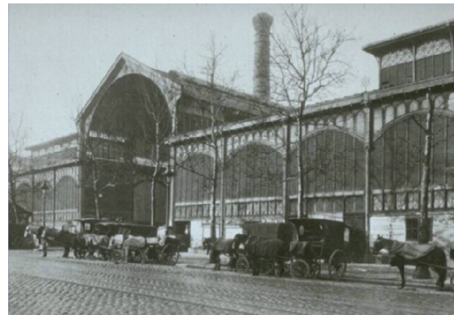
Fig. 19: Detalle de la estructura de Les Halles Centrales.
