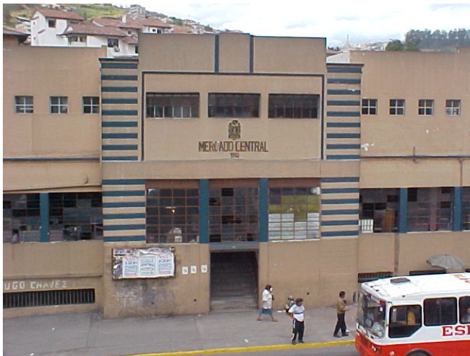
Fig. 44: Mercado Central, antes de su intervención.
