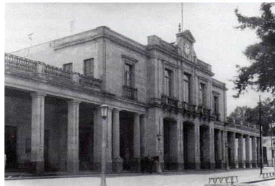
Fig. 8: Edificio Delegacional con explanada peatonal.
