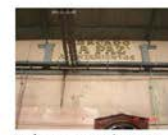
PUESTO CON BARRERA PARA LA CONSTRUCCION INTERIORES DEL MERCADO
