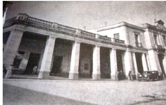
Fig. 7: Edificio Delegacional con calle al frente.
