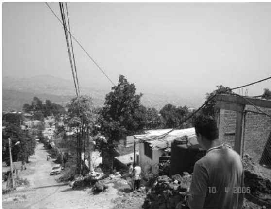
Instalacion Electrica en el 90 por ciento de la zona
