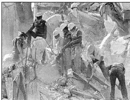
Aquí las ruinas del Hotel Regis colapsado el 19 de septiembre tras el sismo de 8.1 grados en la escala de Richter que golpeó la ciudad de México. En la otra gráfica, policías y rescatistas remueven escombros en un edificio derrumbado en la zona rosa.
